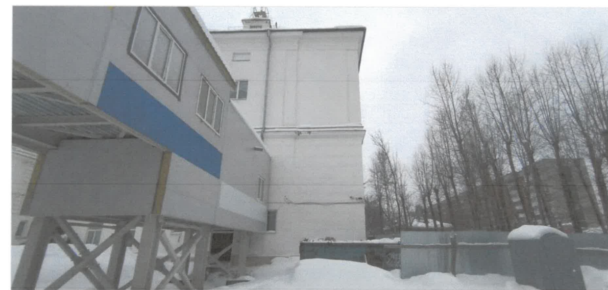
Дворовой фасад (место проектируемого пристраиваемого спортзала)
