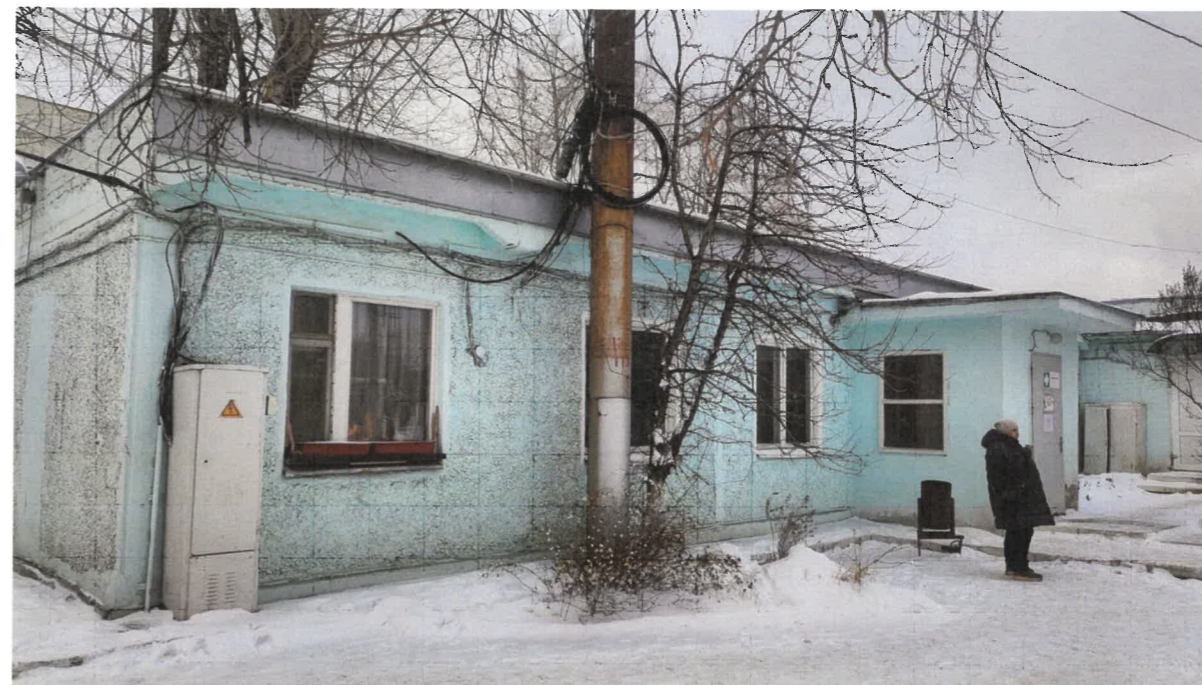
Боковой фасад (в осях 1-3/В)
