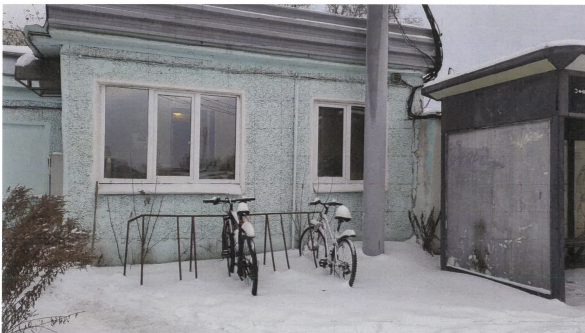
Боковой фасад (в осях 4-5/А)
