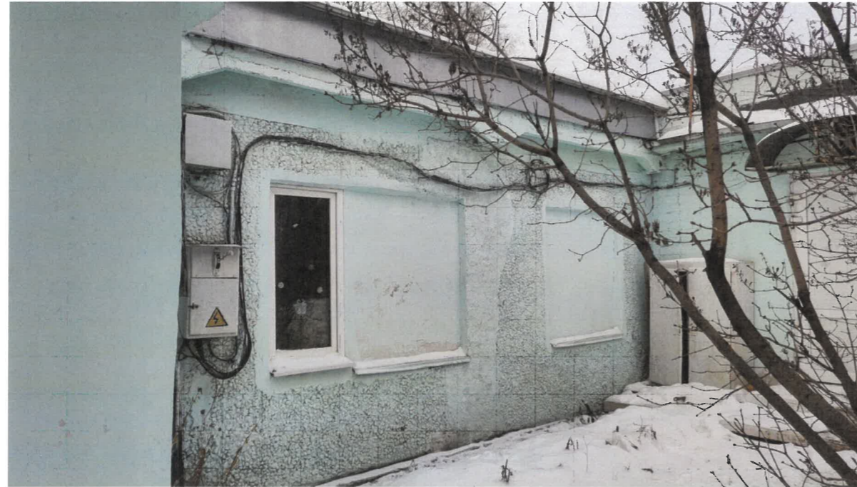
Боковой фасад (в осях 3-4/В)
