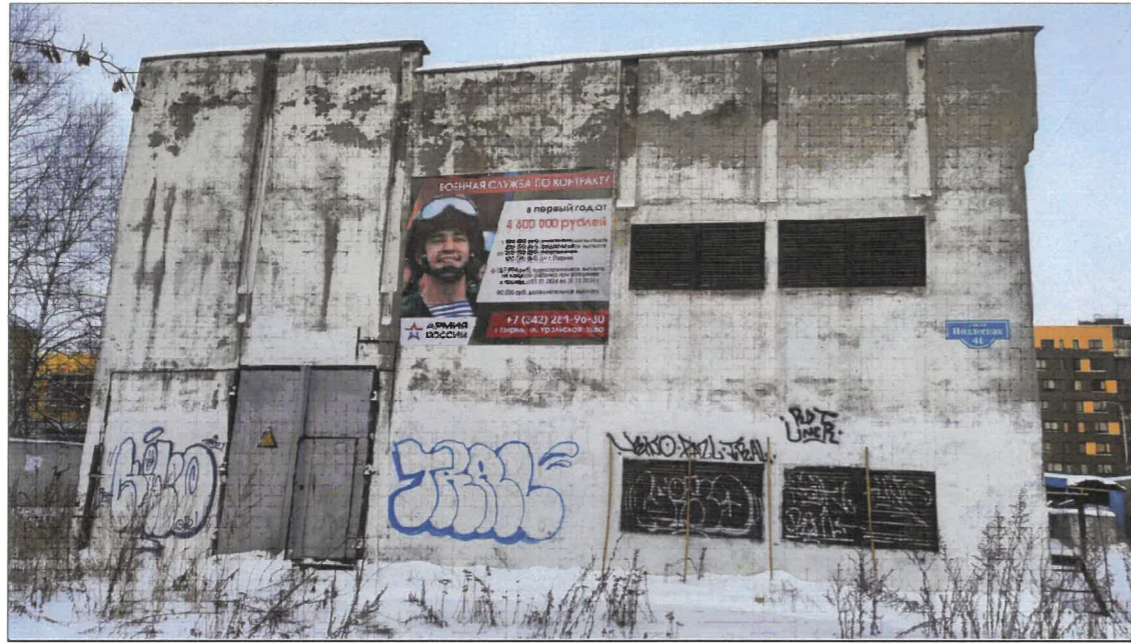
Главный фасад (в осях 1-2)
