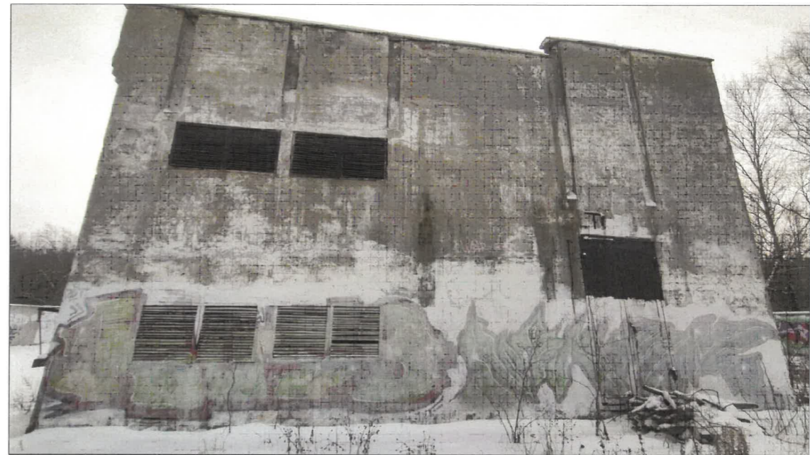
Дворовой фасад (в осях 2-1)
