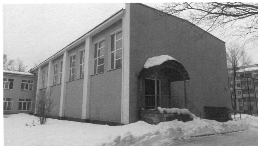
Боковые фасады (Г-Д, 3-4 по ул. Крупской)
