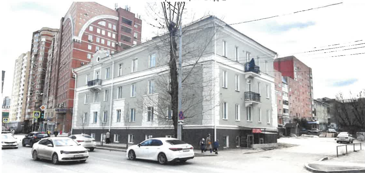
Фотофиксация. Вид Е
