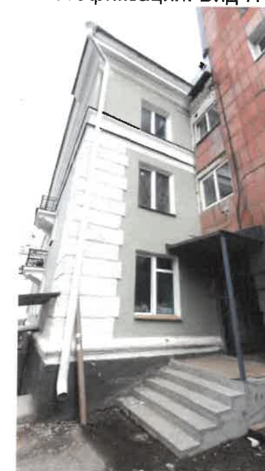
Фотофиксация. Вид Н
