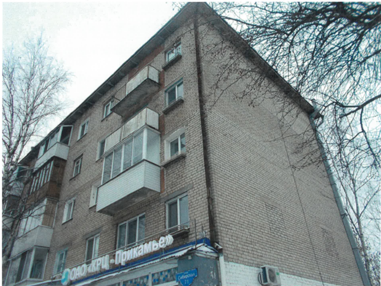
Фото 4. Боковой фасад со стороны ул. Сибирская.
