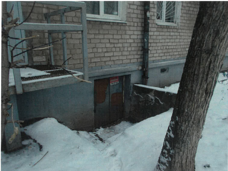
Фото 6. Вход в подвал ж. дома № 1.
