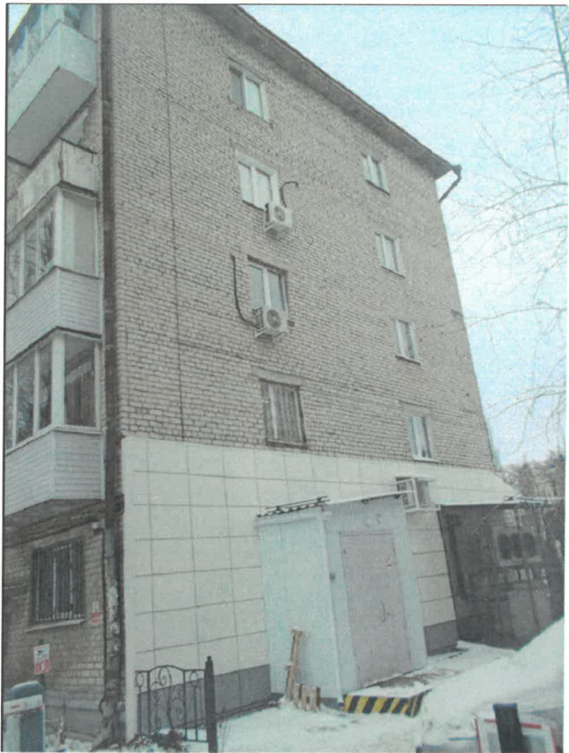
Фото 3. Боковой фасад со стороны ул. Белинского
