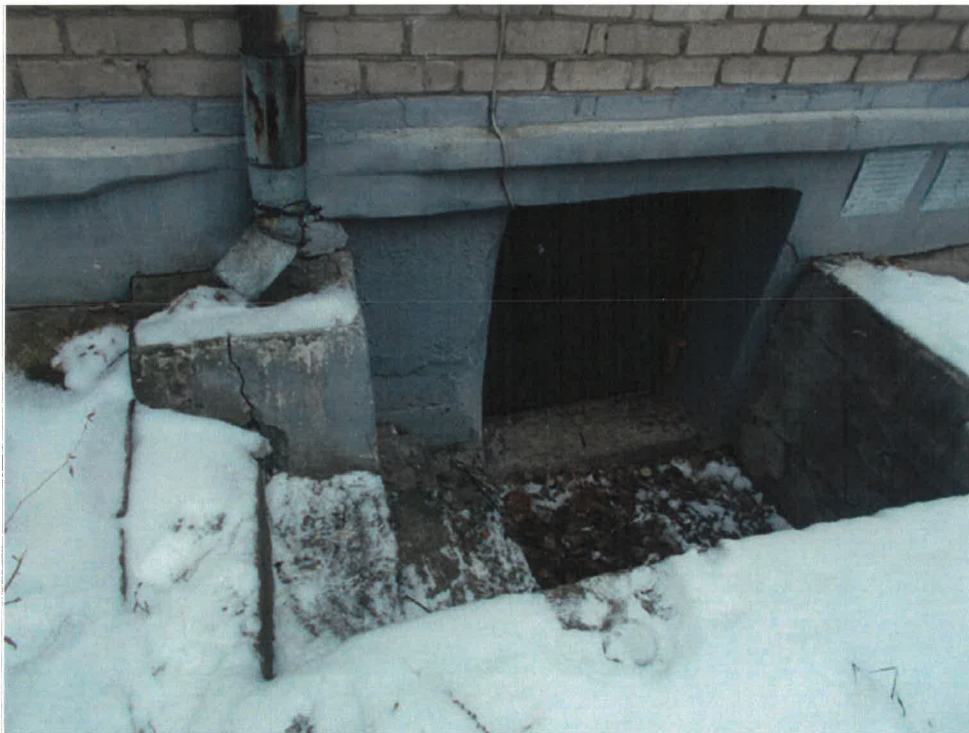
Фото 7. Вход в подвал жилого дома № 2.
