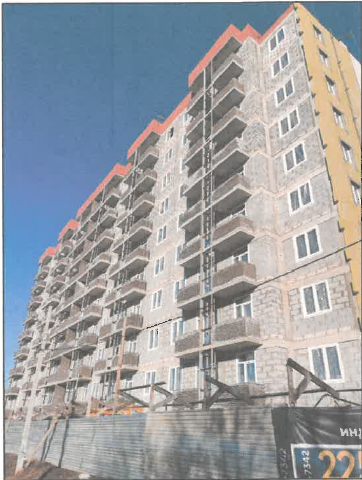
Существующее состояние главного фасада
