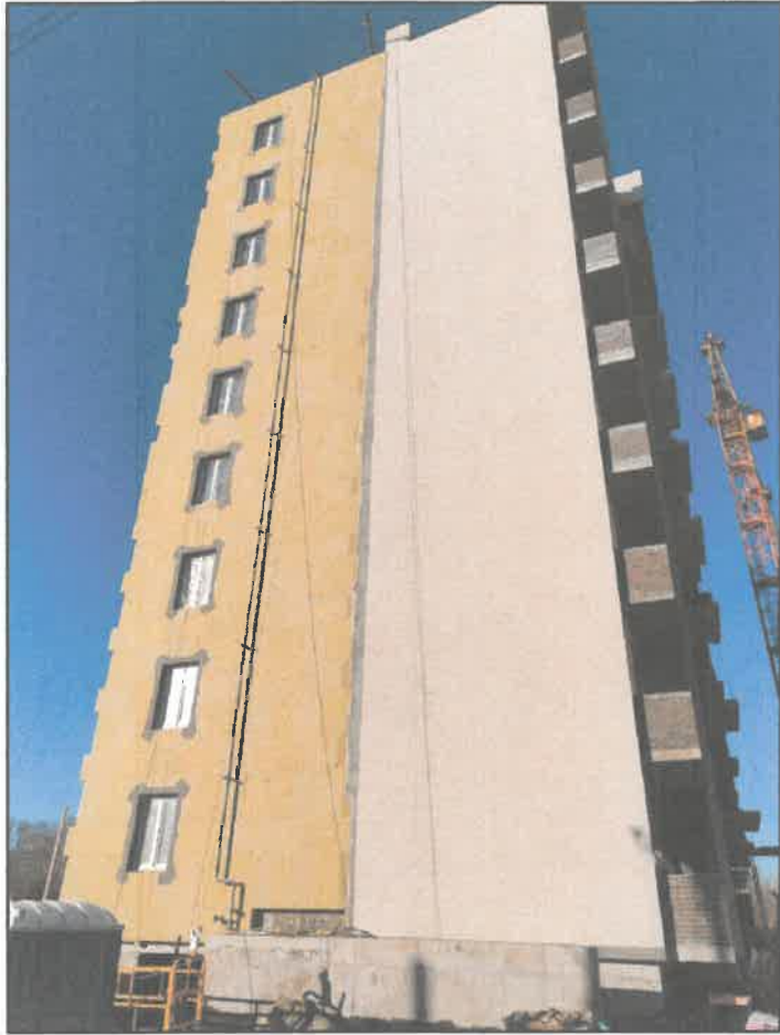
Существующее состояние бокового фасада
