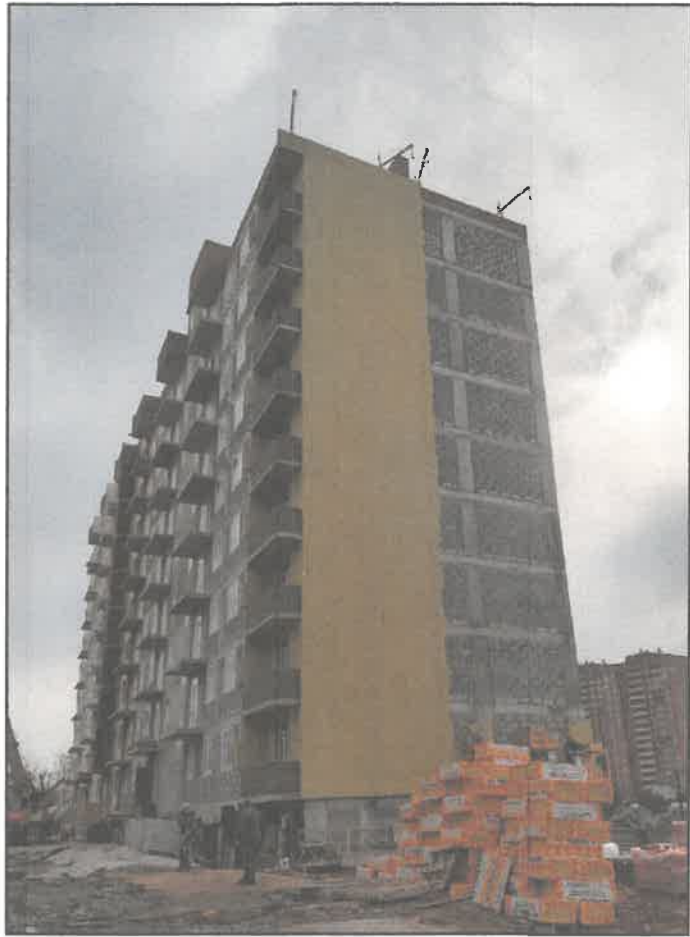
Существующее состояние бокового и дворового фасадов
