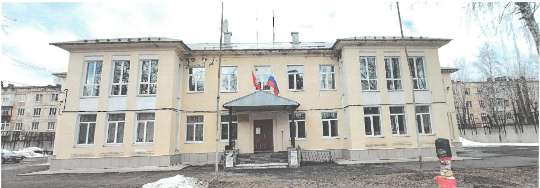
Существующее состояние фасадов. Боковые фасады.
