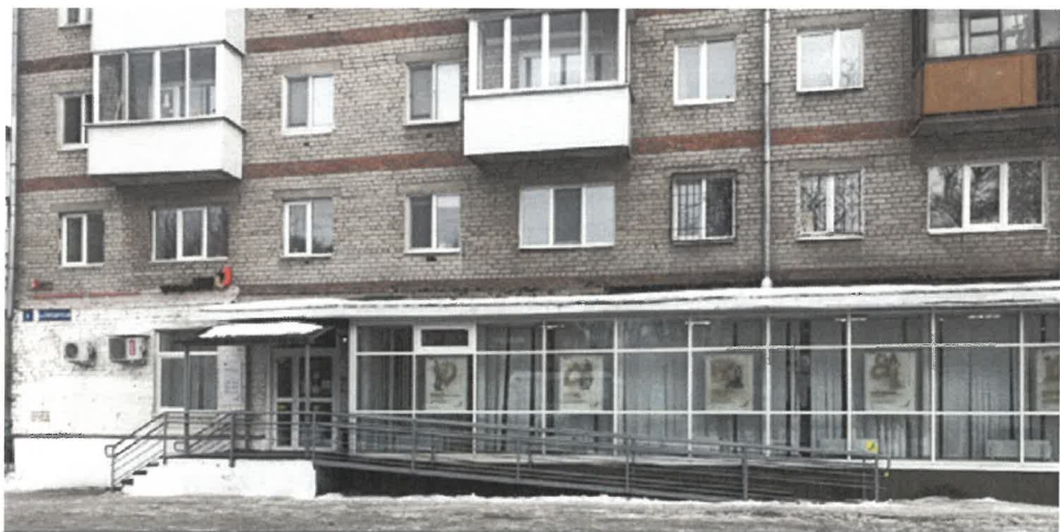
Главный фасад в осях 1-2
