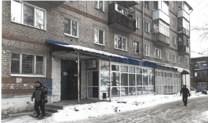
Главный фасад в осях 2-3
