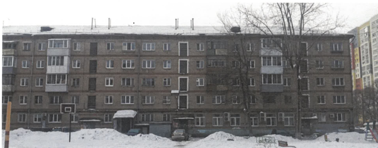
Дворовой фасад в осях 2-1
