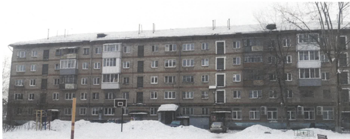
Дворовой фасад в осях 3-2
