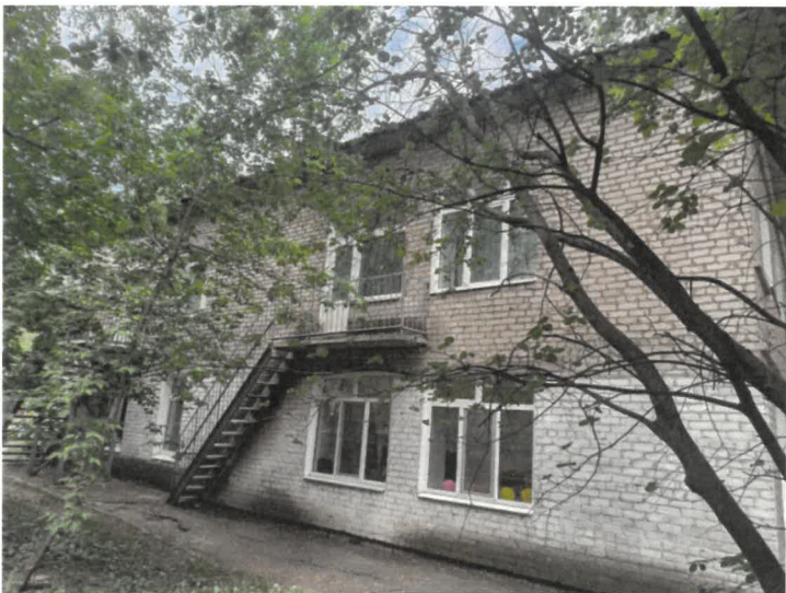
Боковой фасад в осях 3-1
