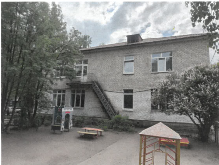
Боковой фасад в осях 1-3
