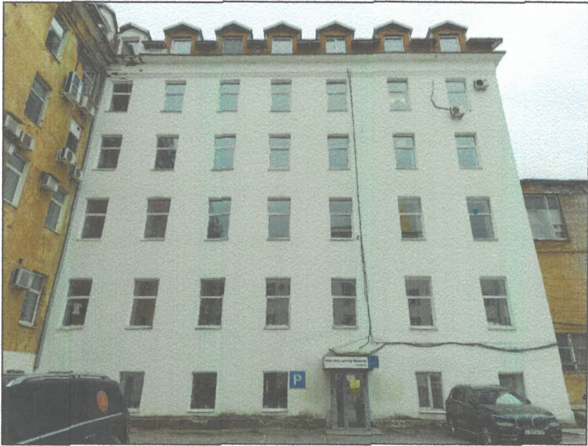
Дворовой фасад (Г-Д/2)
