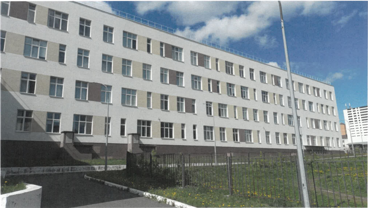
Дворовой фасад (с в осях Б-А)
