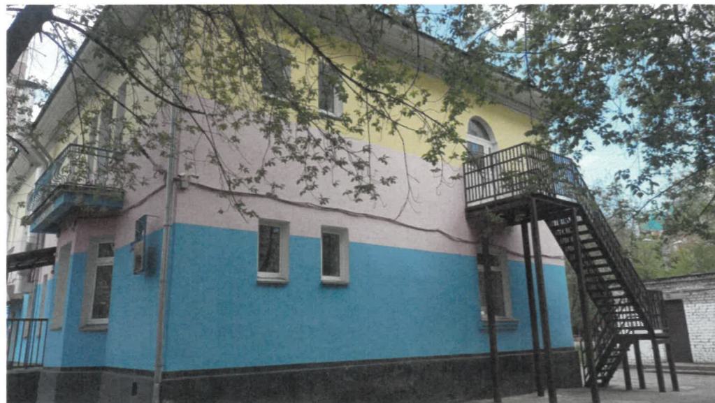
Боковой фасад в осях 2-1
