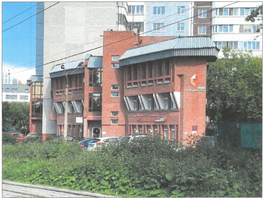
Существующее состояние бокового фасада в осях Б-Д
