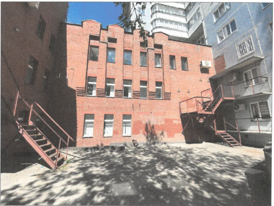
Существующее состояние дворового фасада в осях 3-1
