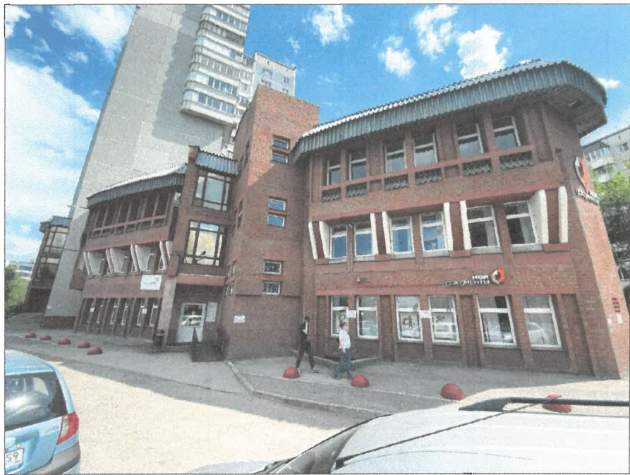
Существующее состояние главного фасада в осях 2-6
