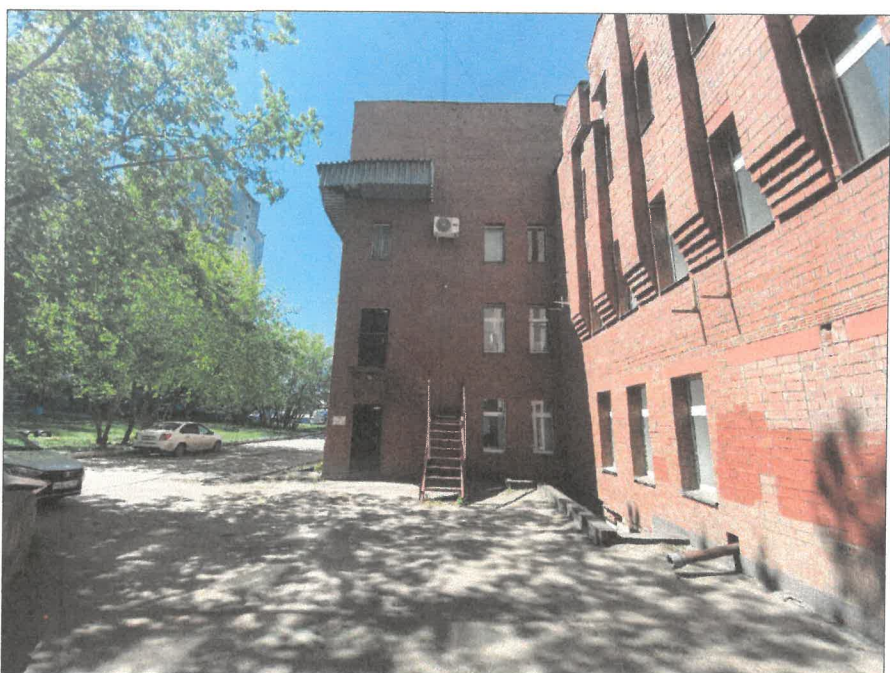
Существующее состояние бокового фасада в осях Д-Г
