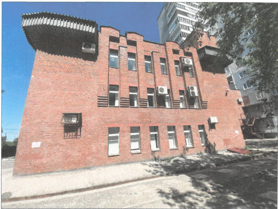
Существующее состояние дворового фасада в осях 6-3
