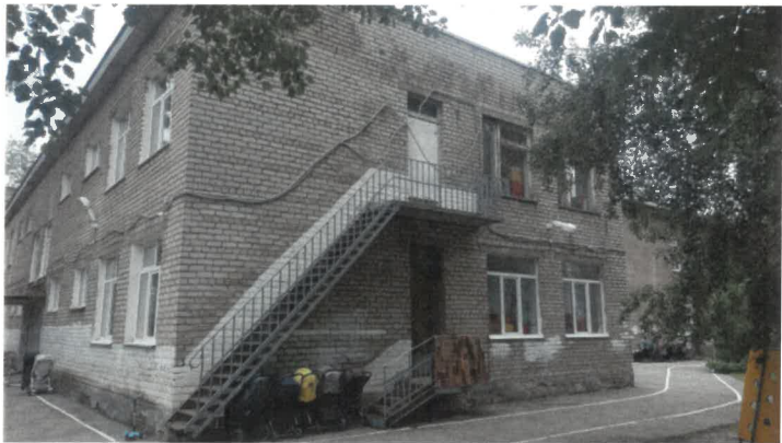
Боковой фасад (в осях 4-3)
