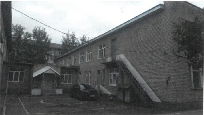
Фасад (в осях Г-В)
