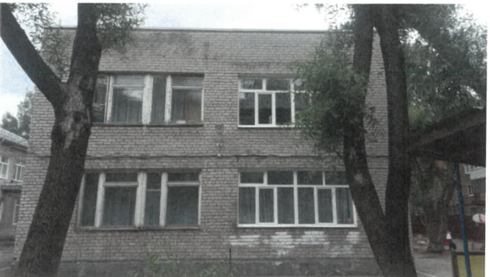
Боковой фасад (в осях 3-4)
