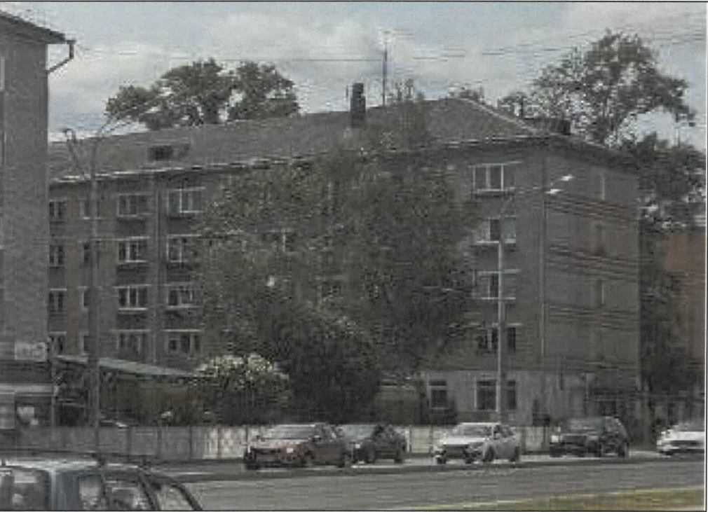
Существующее состояние дворового фасада
