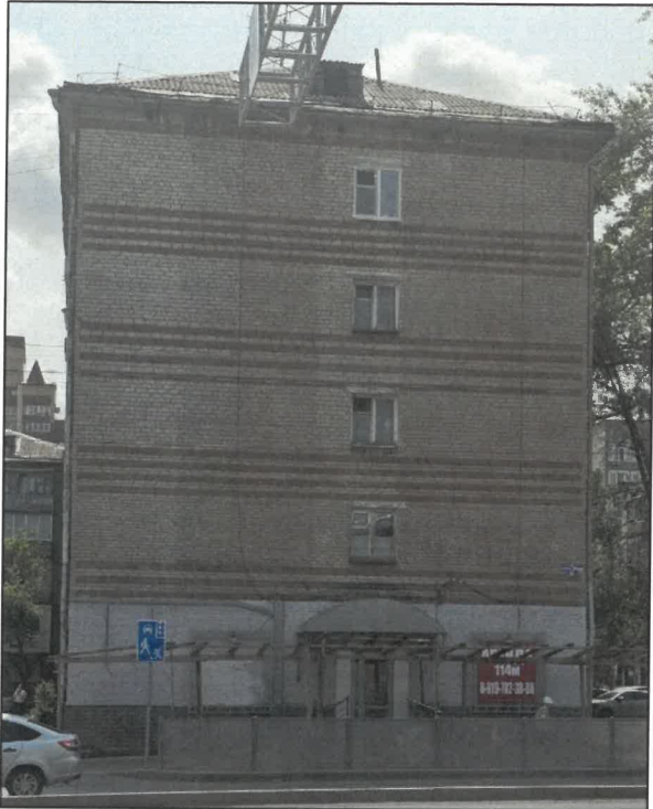
Существующее состояние фасада со стороны ул.Революции
