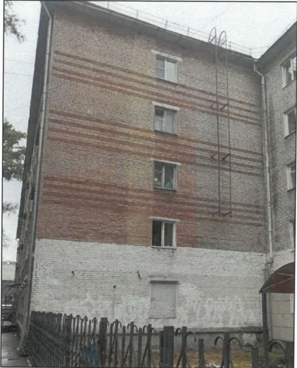
Существующее состояние фасада со стороны ул.Швецова
