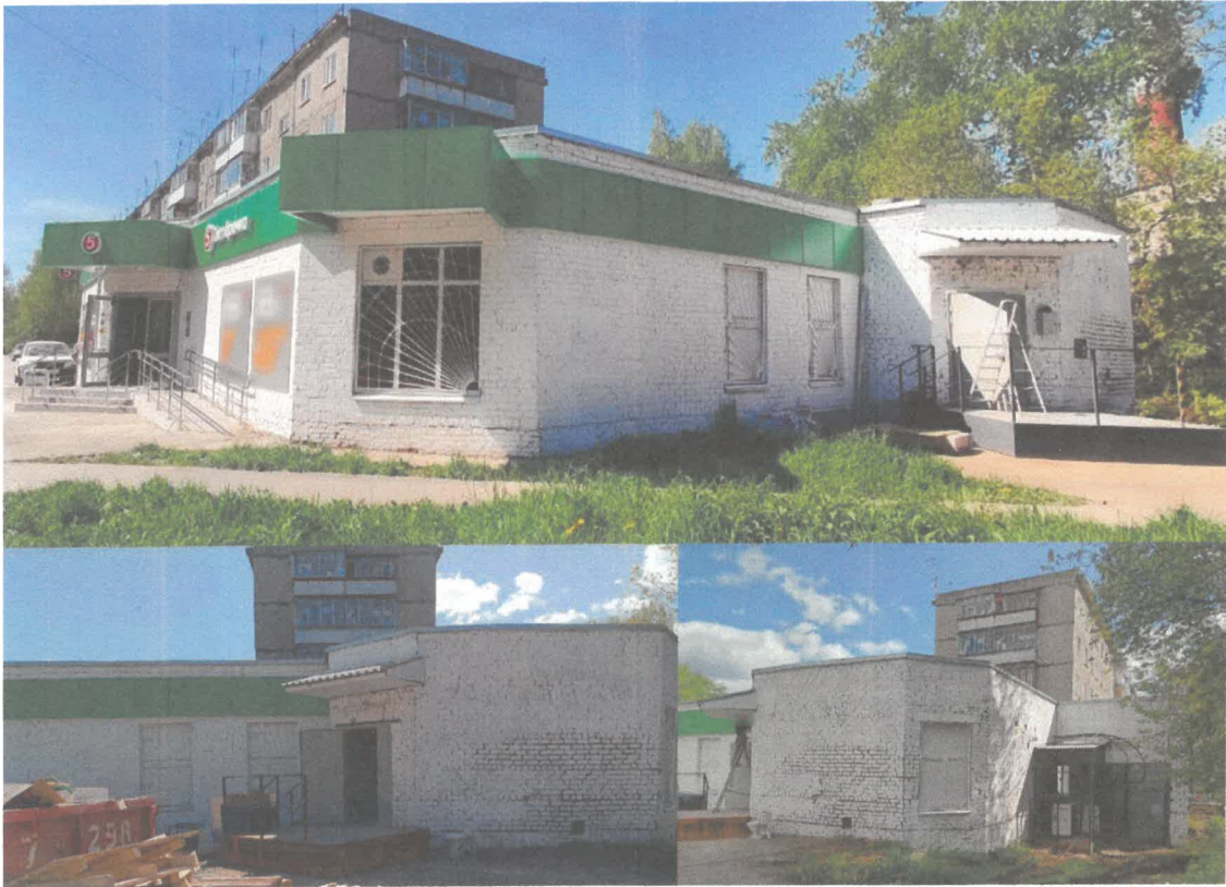
Боковой фасад Дата съемки: 15.06.2025
