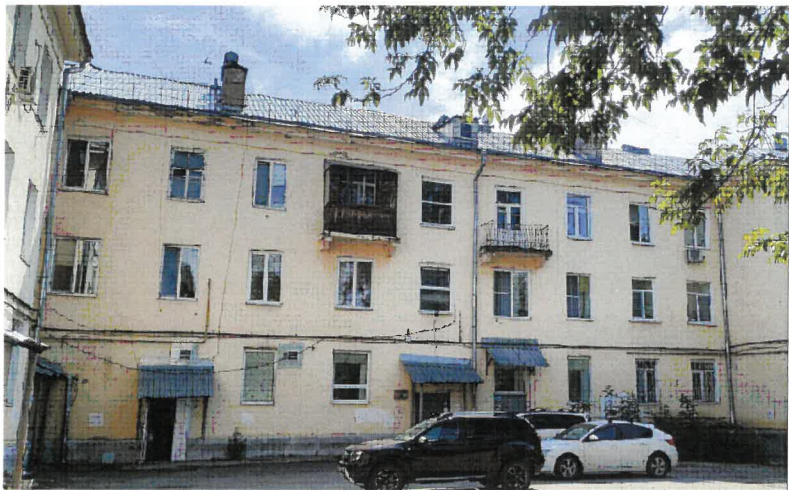
Дворовой фасад в осях 2-3
