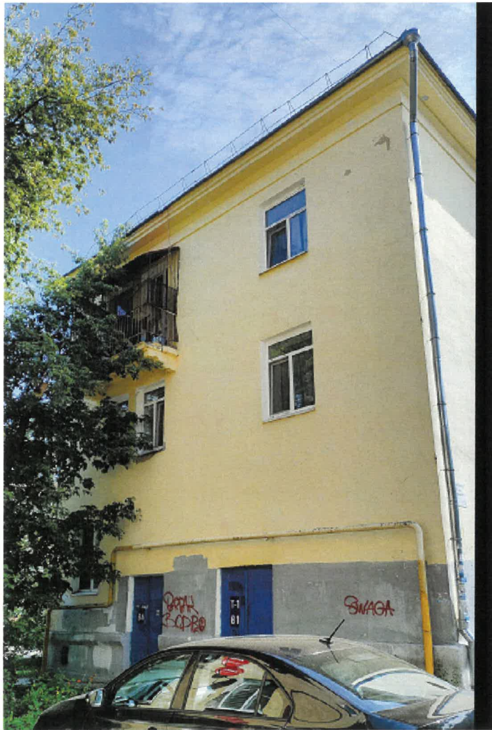
Боковой фасад в осях 4-3
