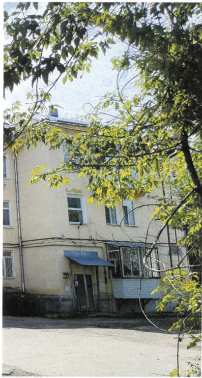
Дворовой фасад в осях 2-1
