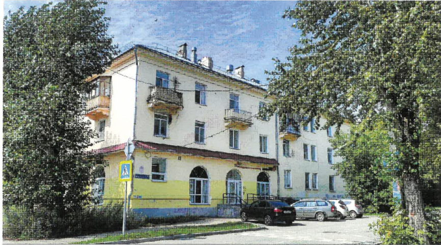
Главный фасад в осях Г-А
