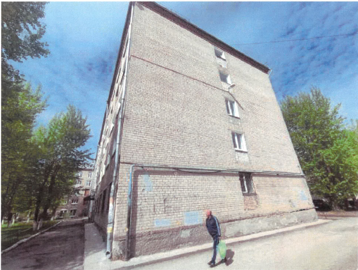
Боковой фасад в осях В-И/32
