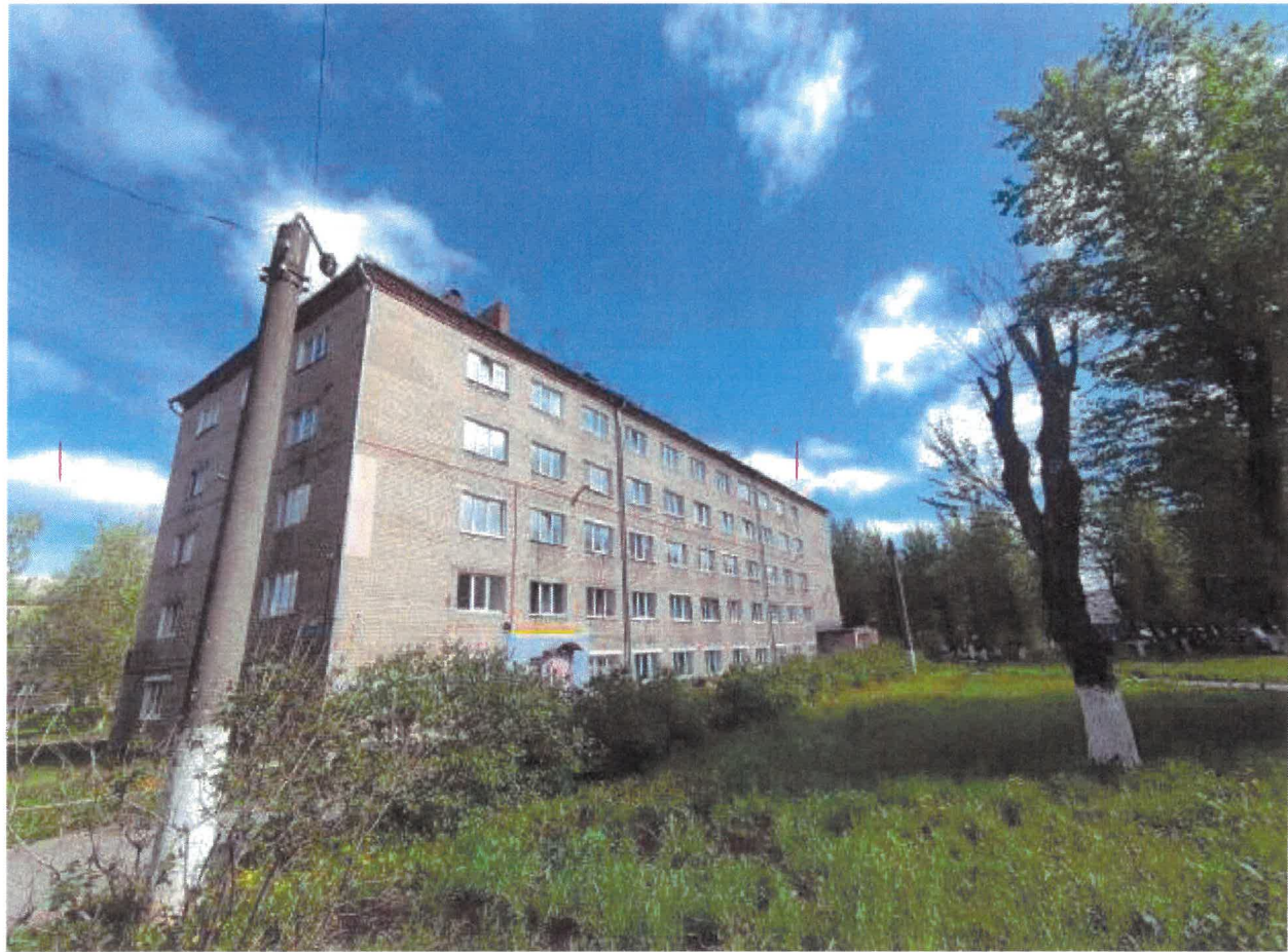
Главный фасад в осях А/1-32
