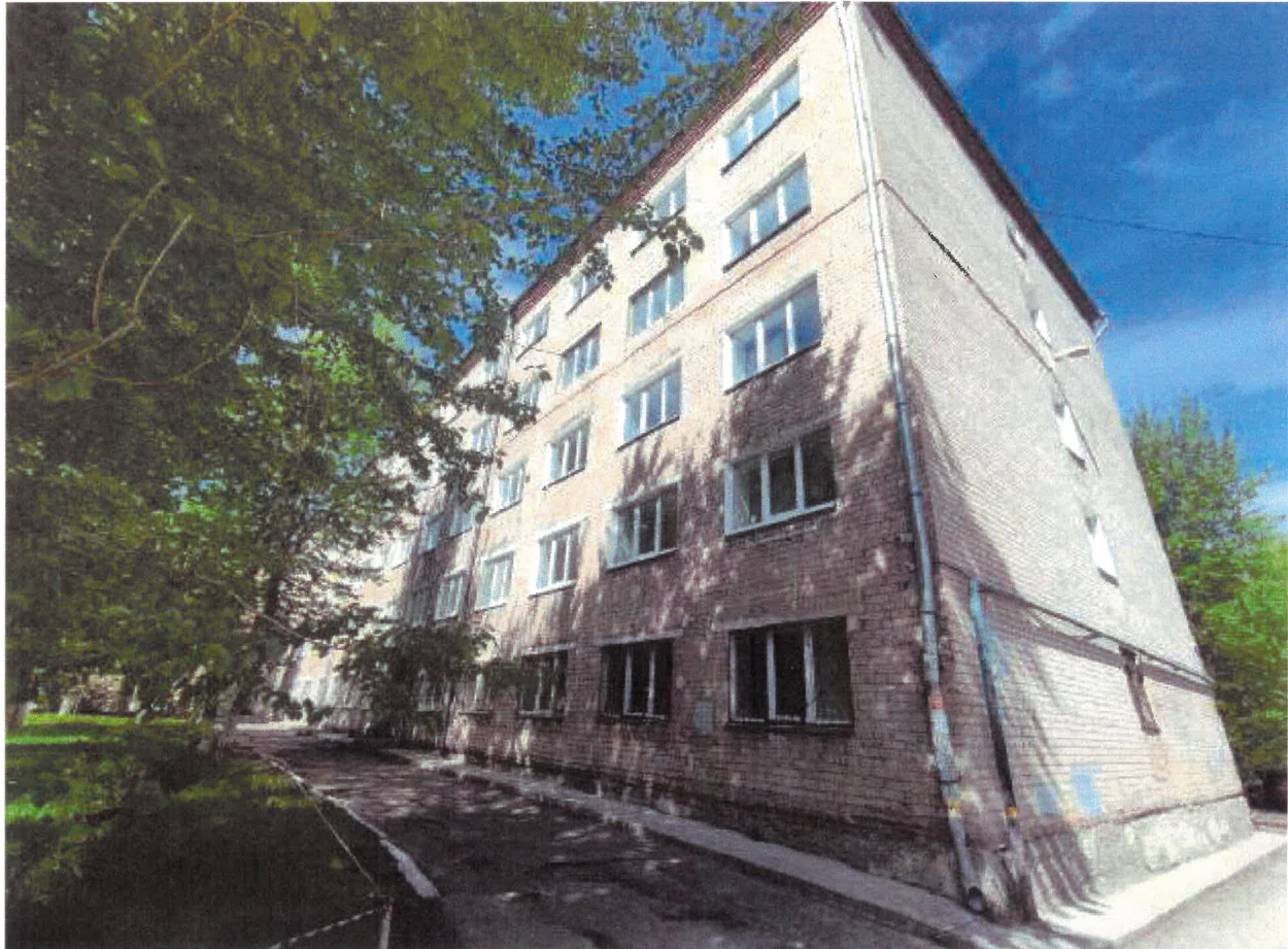
Главный фасад в осях А/1-32
