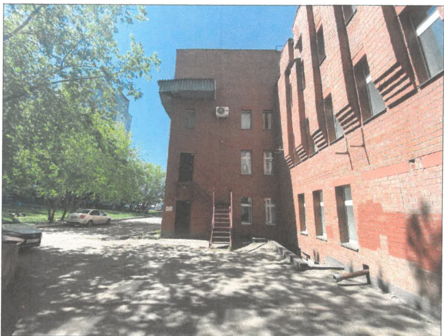
Существующее состояние бокового фасада в осях Д-Г
