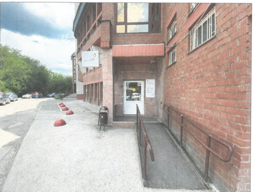
Существующее состояние главной входной группы
