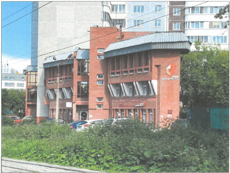
Существующее состояние бокового фасада в осях Б-Д
