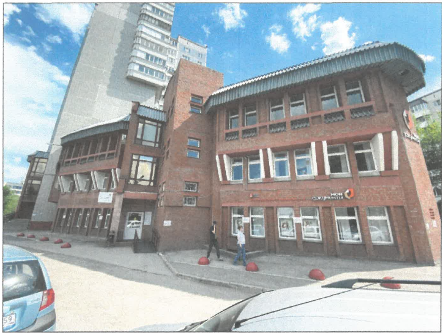
Существующее состояние главного фасада в осях 2-6
