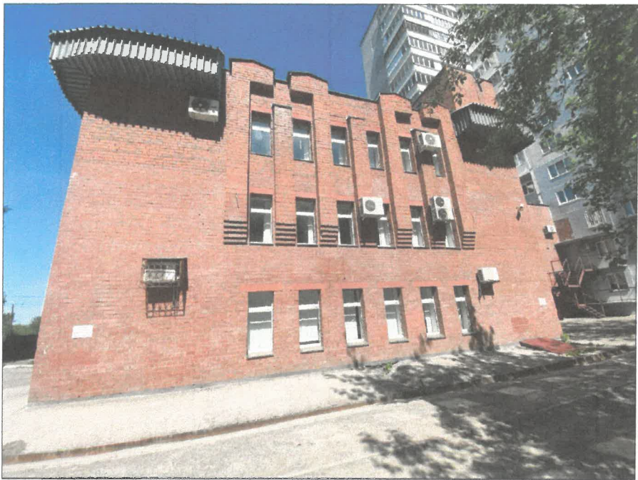
Существующее состояние дворового фасада в осях 6-3
