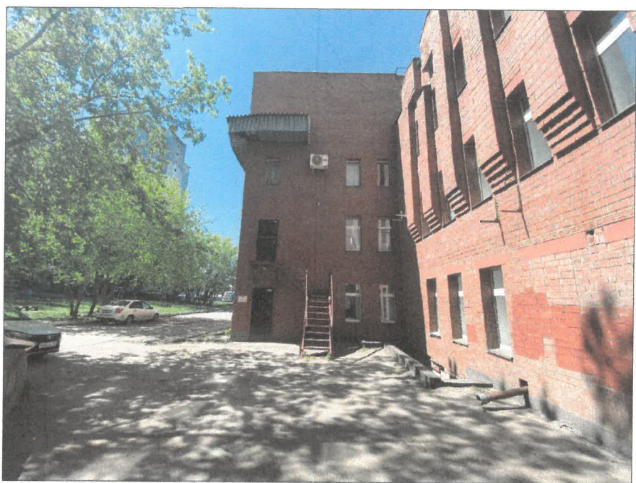
Существующее состояние бокового фасада в осях Д-Г
