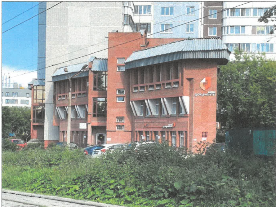
Существующее состояние бокового фасада в осях Б-Д
