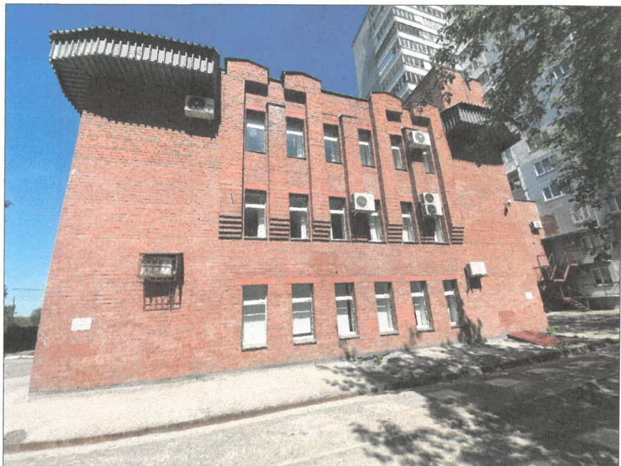
Существующее состояние дворового фасада в осях 6-3
