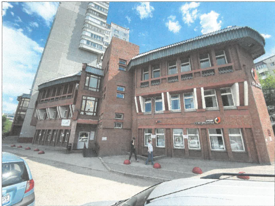
Существующее состояние главного фасада в осях 2-6
