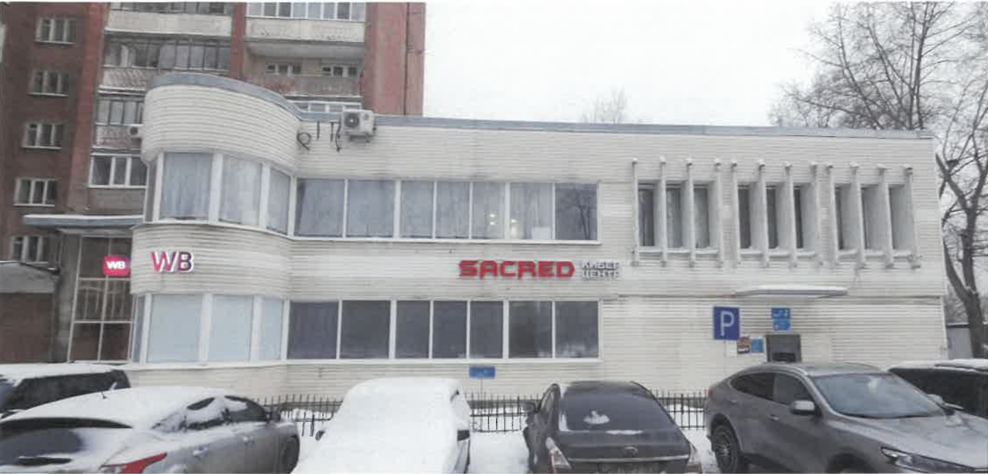
Существующее состояние главного фасада (фотофиксация вид Д)
