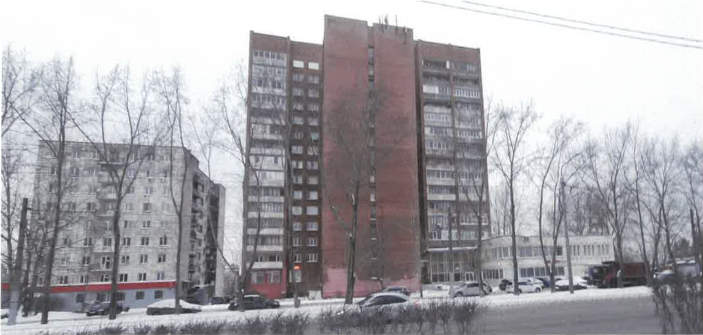
Существующее состояние главного фасада (фотофиксация вид Б)
