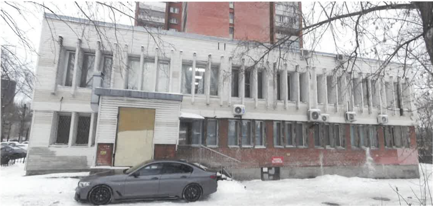
Существующее состояние бокового фасада (фотофиксация вид Ж)
