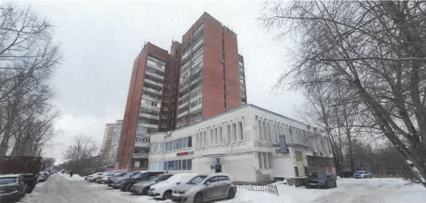
Существующее состояние главного фасада (фотофиксация вид А)
