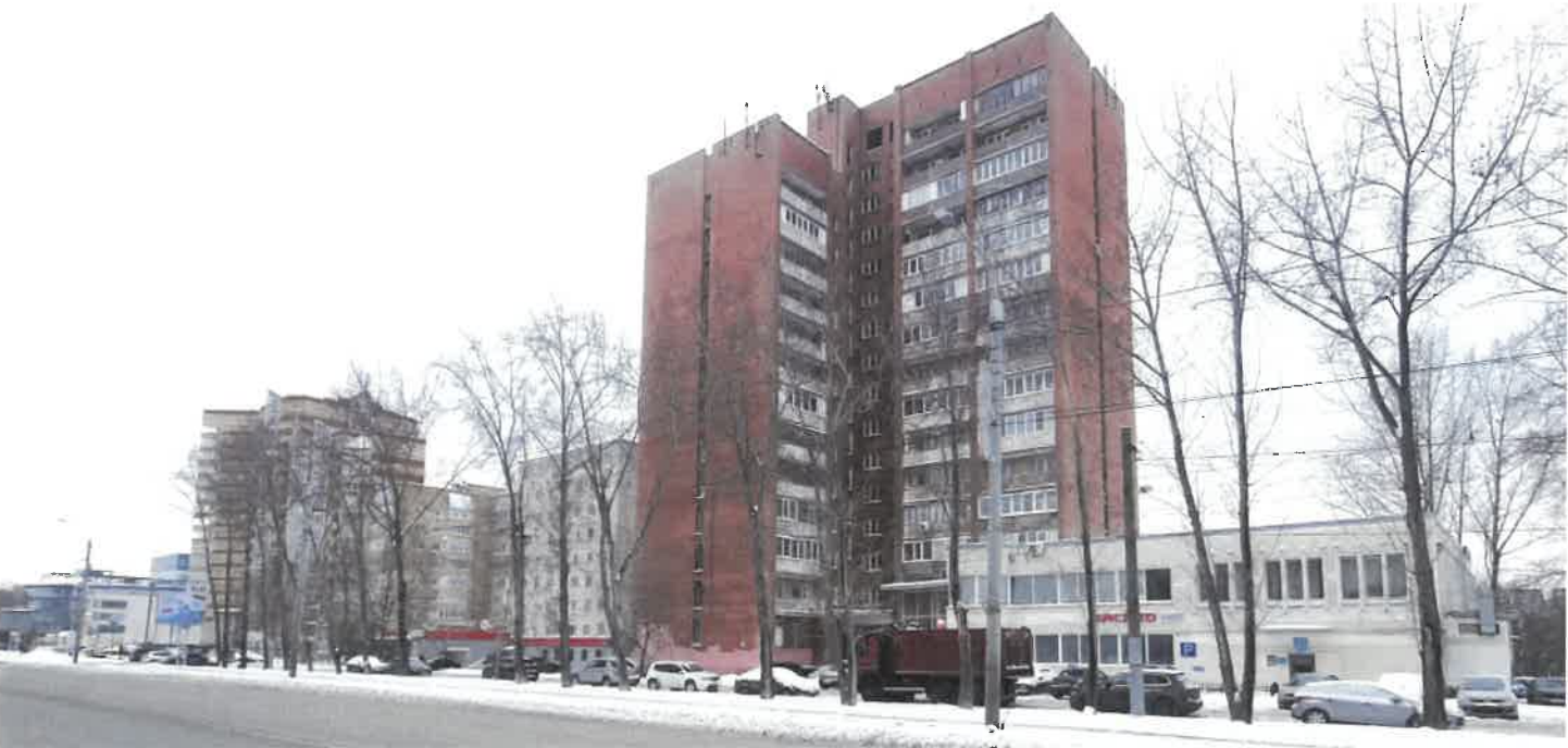
Существующее состояние главного фасада (фотофиксация вид В)
