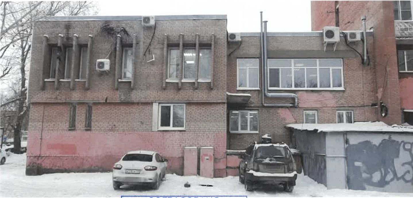
Существующее состояние дворового фасада (фотофиксация вид И)
