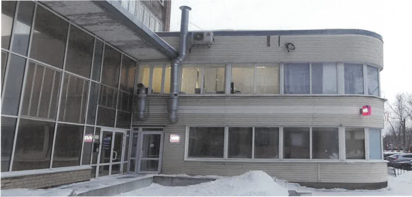
Существующее состояние главного фасада (фотофиксация вид Е)
