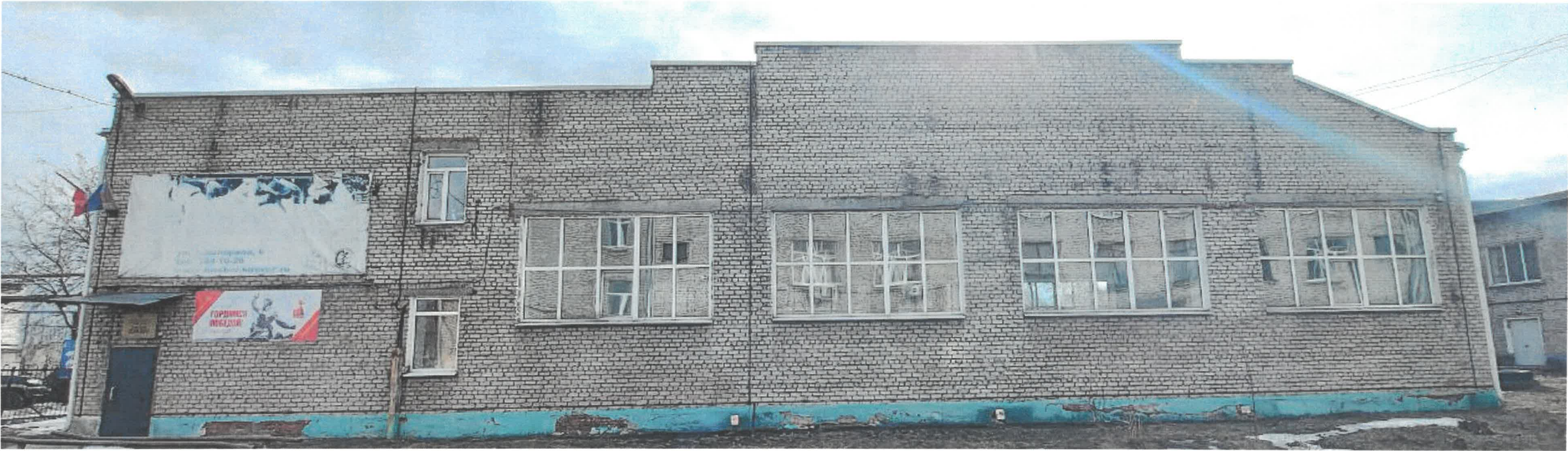
Существующее состояние фасадов. Боковые фасады.
