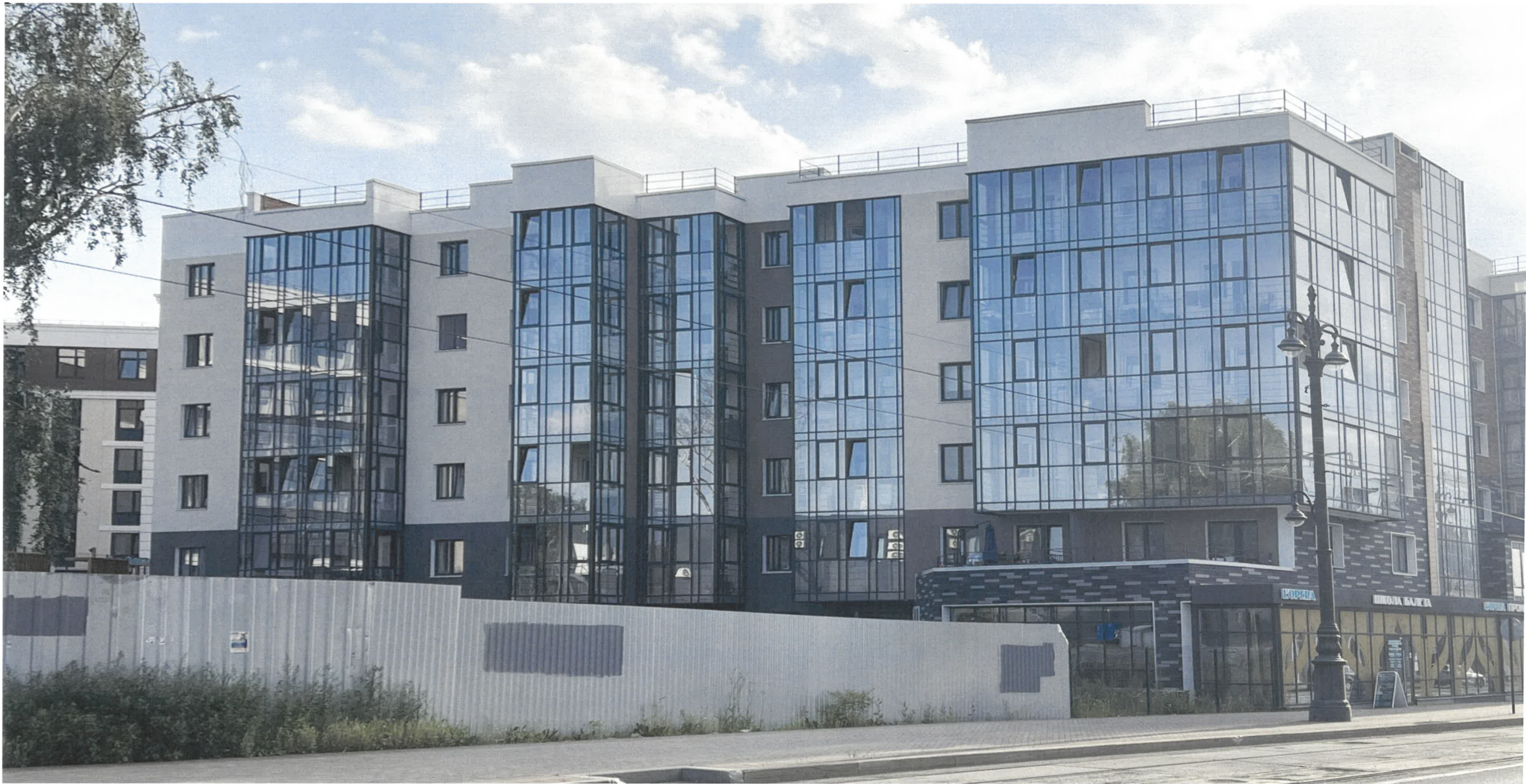
Дворовой фасад (июль, 2025 г.)
