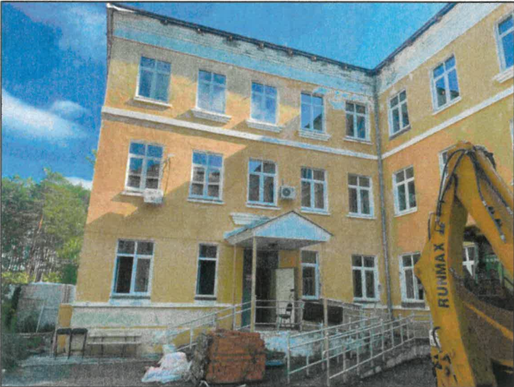
Фасад в осях 7/Ж-Е
