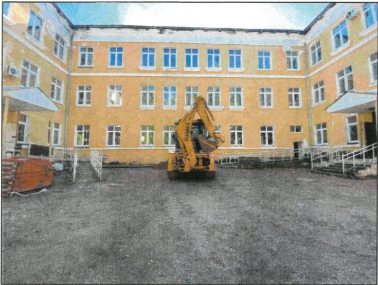
Главный фасад в осях 7-4
