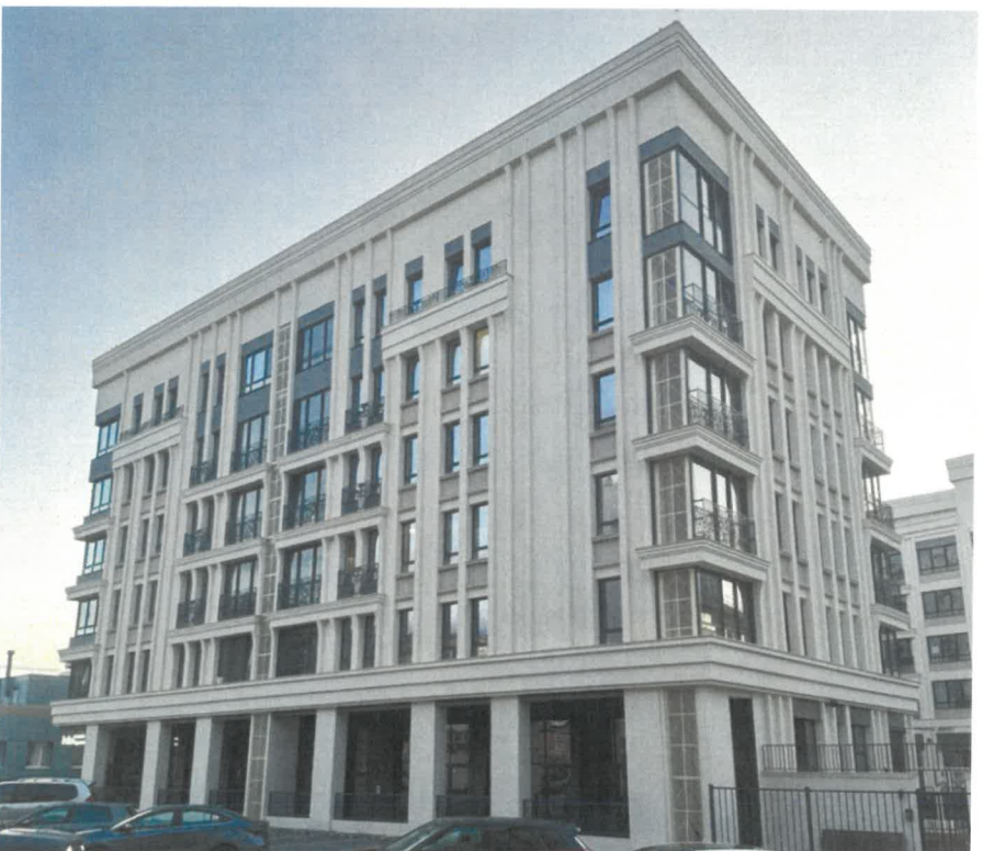
Дворовой фасад. Вид со стороны ЦУМа Фотофиксация выполнена 3.07.2025 г.
