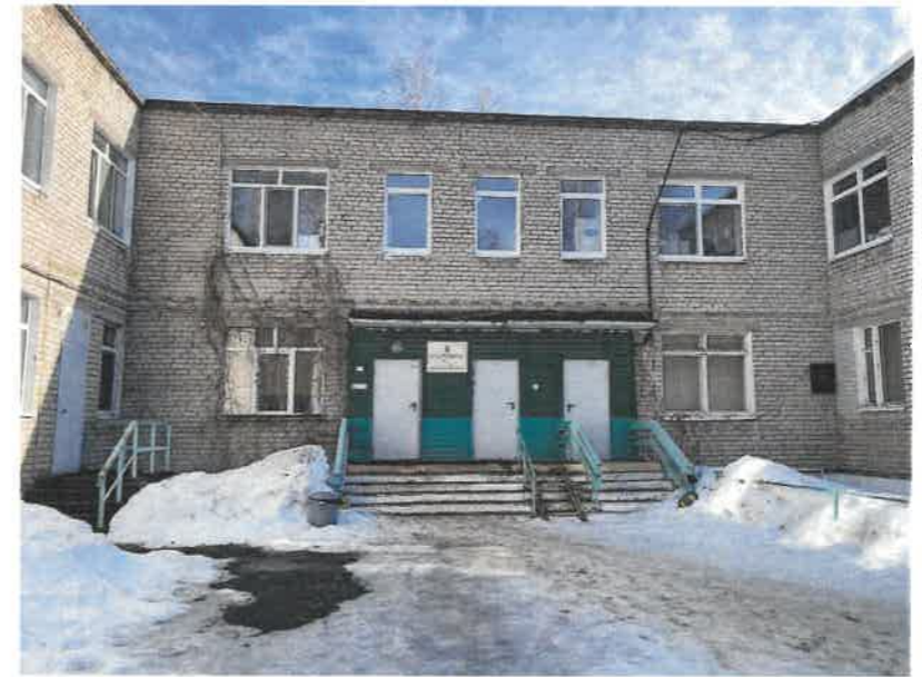
Главный фасад (Вид Е)
