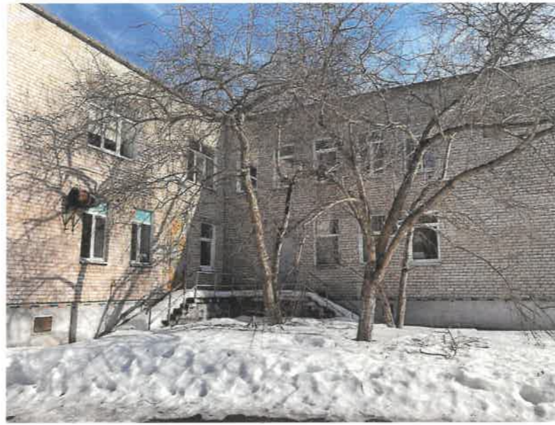
Главный фасад (Вид И)
