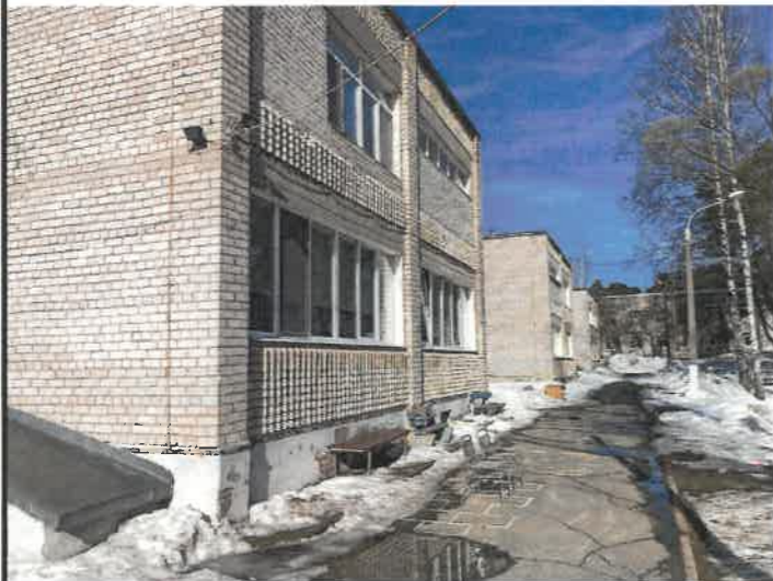
Дворовый фасад (Вид Л)
