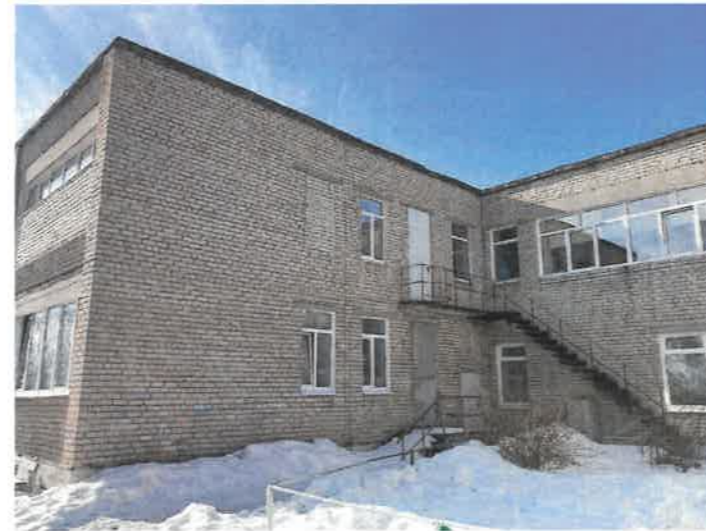
Дворовый фасад (Вид М)
