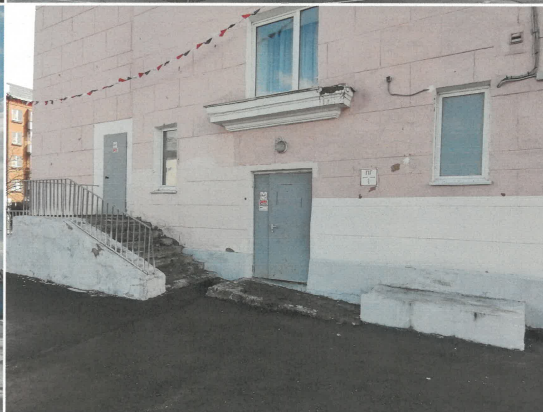
Фрагмент дворового фасада в осях 4-3
