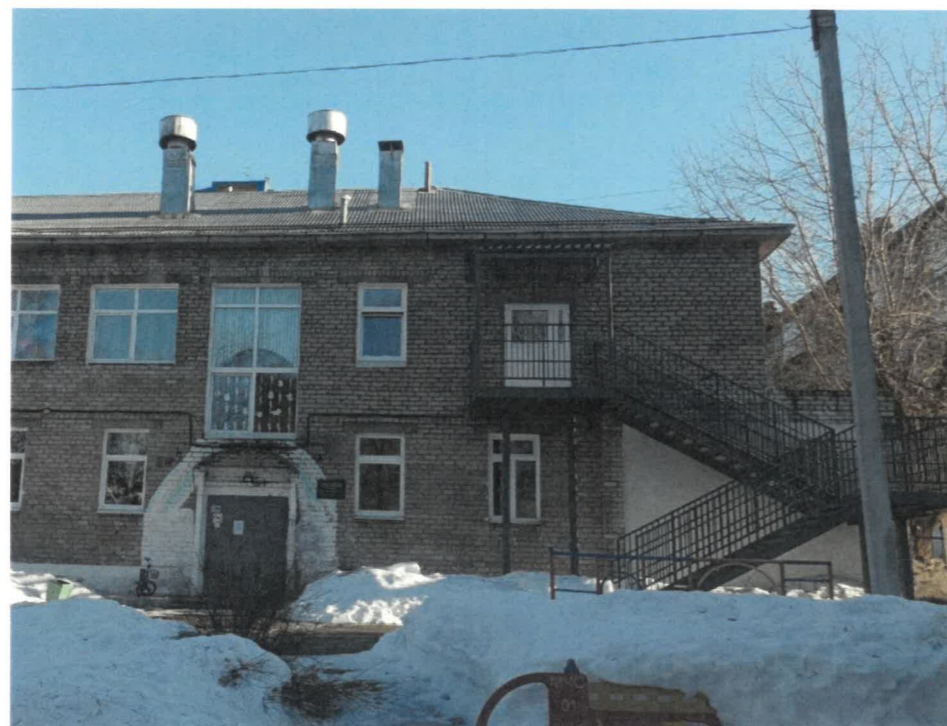
Дворовой фасад (в осях Б-А)
