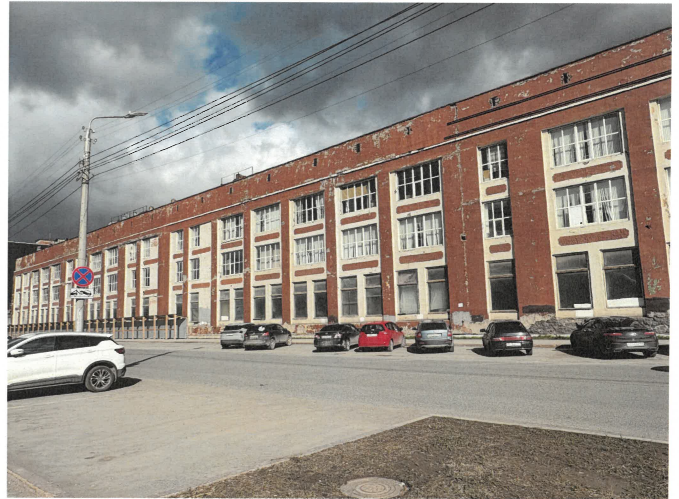
Главный фасад по оси А.
