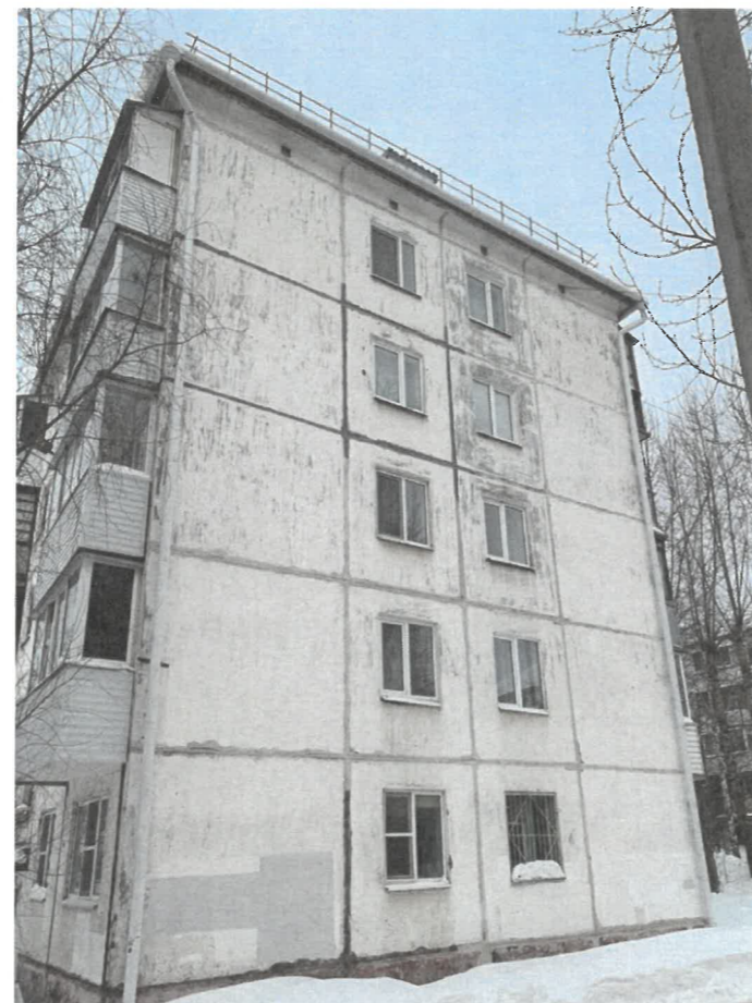
Существующее состояние бокового фасада
