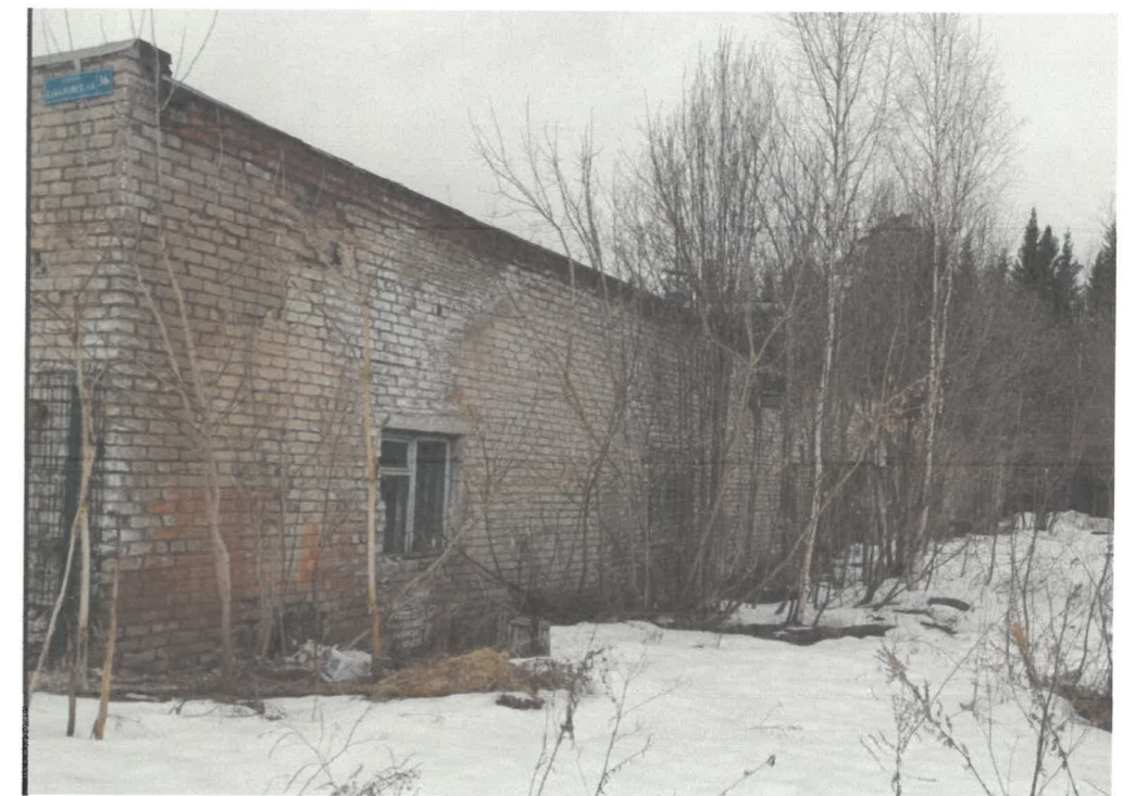
Боковой фасад в осях А-4
