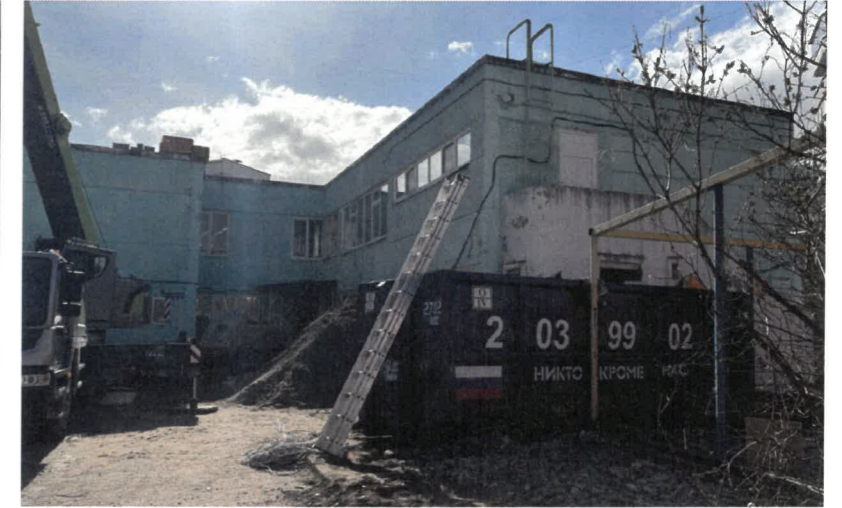
Главный фасад в осях 14-1
