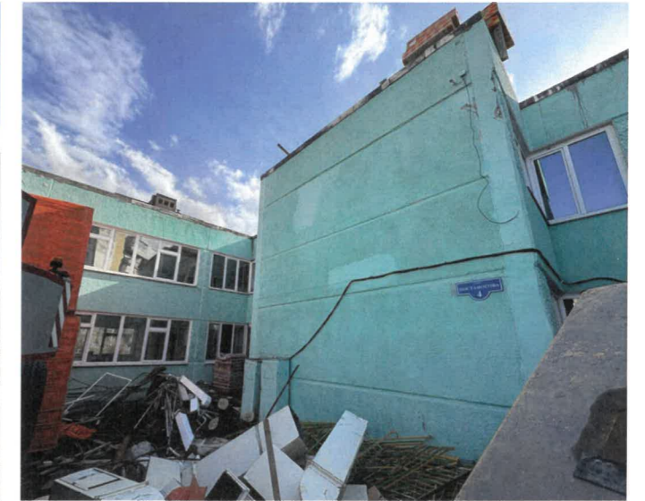
Часть главного фасада в осях 14-1
