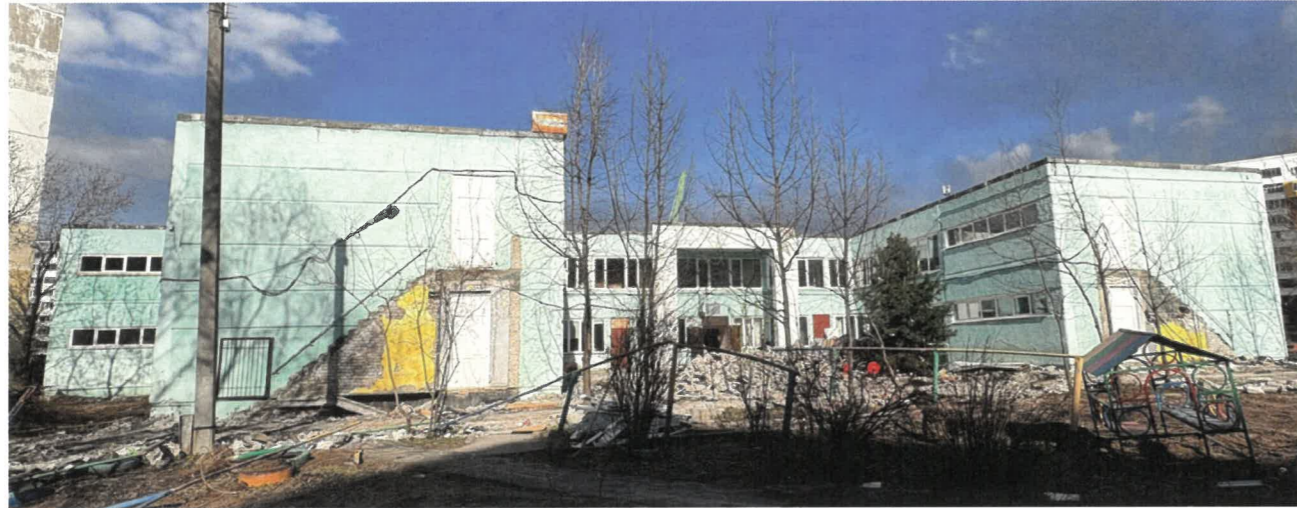
Дворовой фасад в осях 1-14
