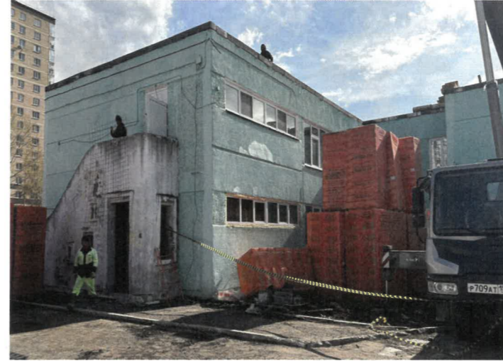
Главный фасад в осях 14-1
