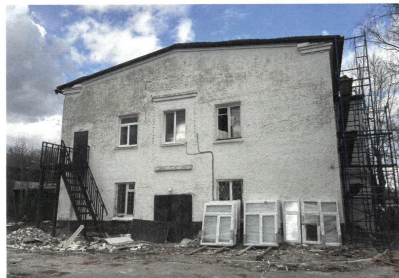
Часть фасада А-К
