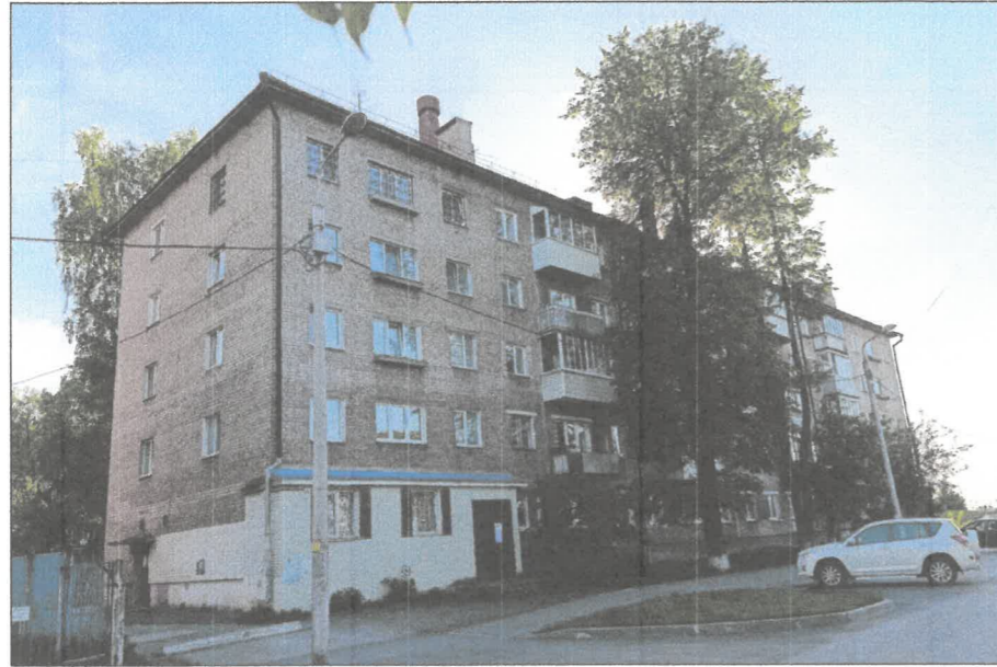
Главный фасад по ул. Барамзиной
