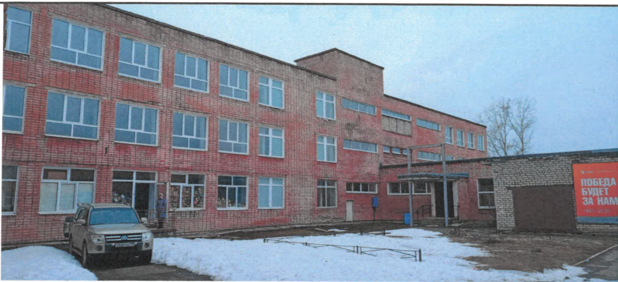
Фрагмент дворовых фасадов в осях 1-5 и Д-А
