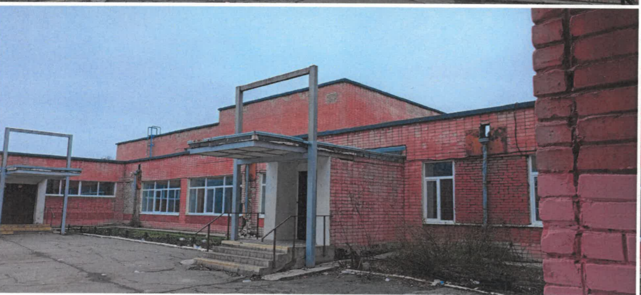
Фрагмент дворовых фасадов в осях 4-1
