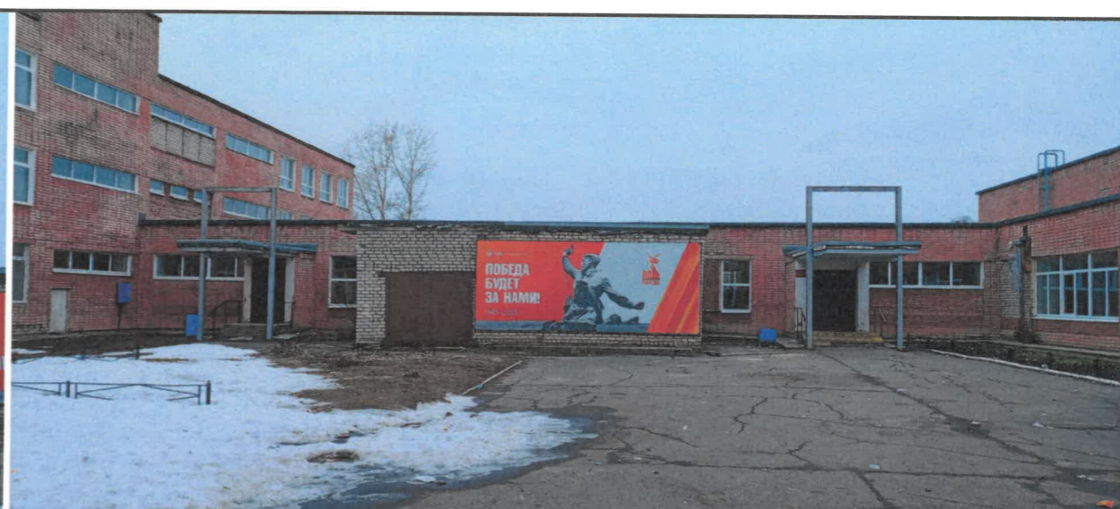
Фрагмент дворовых фасадов в осях 1-5 и Д-А
