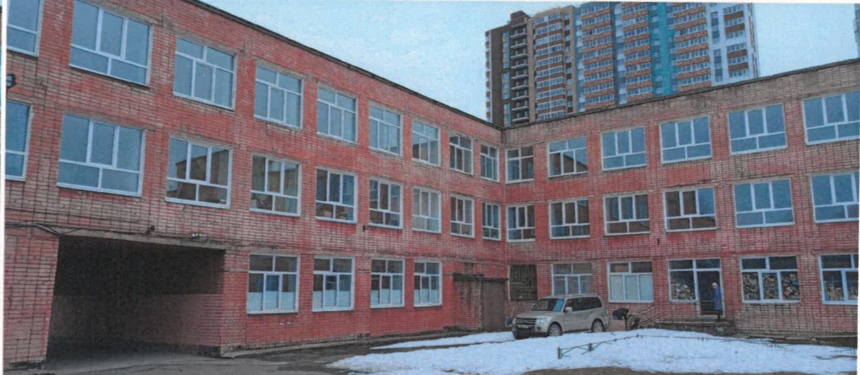
Фрагмент дворовых фасадов в осях Б-Д и 1-5
