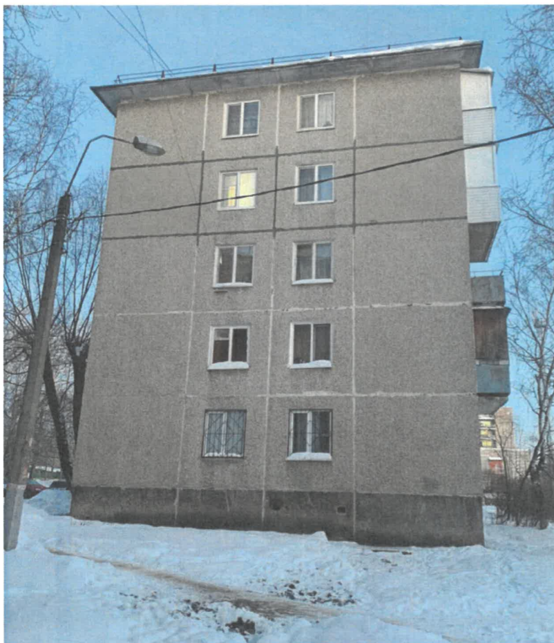
Существующее состояние бокового фасада
