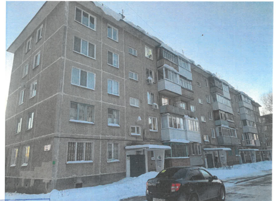
Существующее состояние главного фасада
