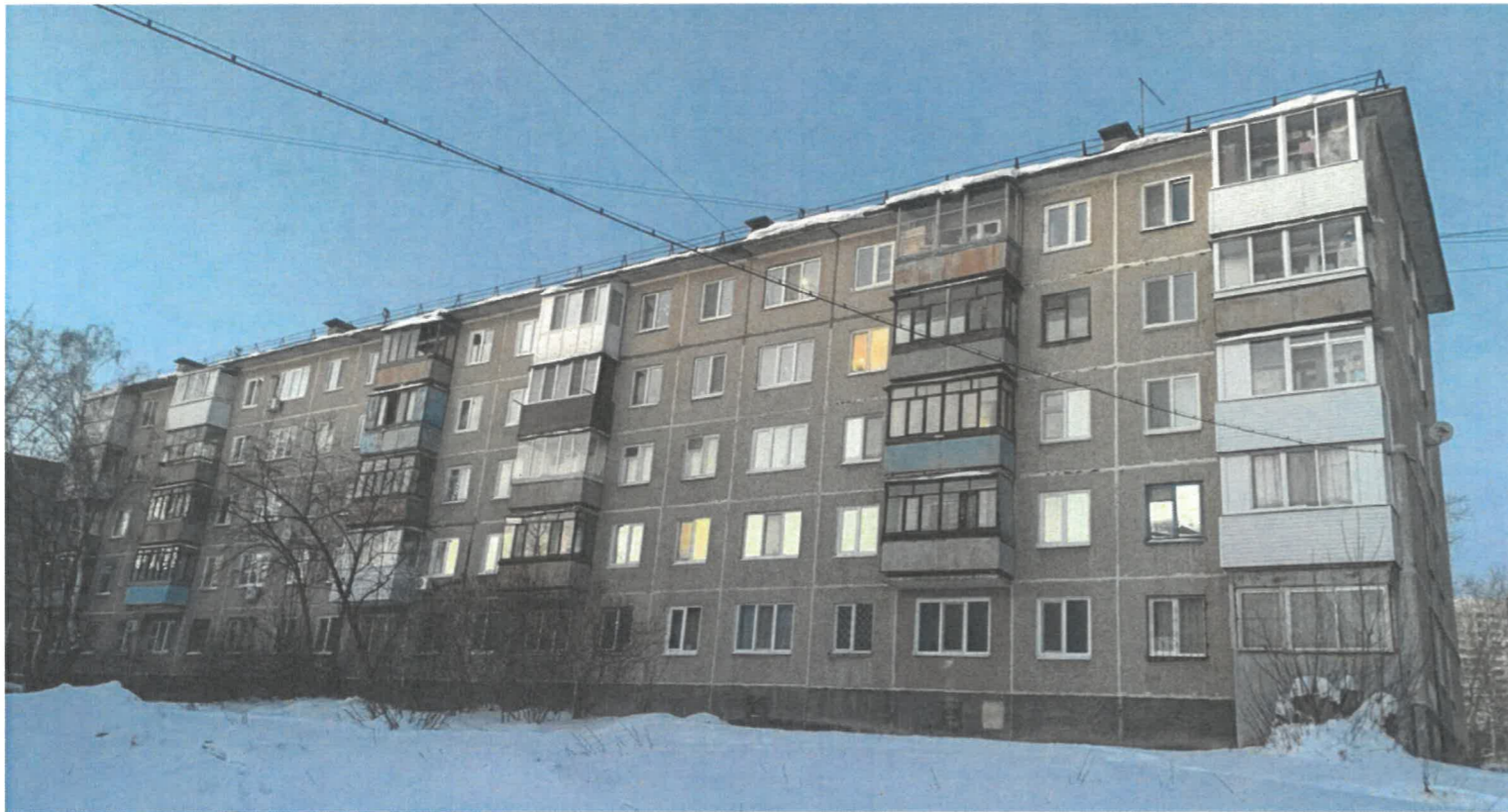
Существующее состояние дворового фасада
