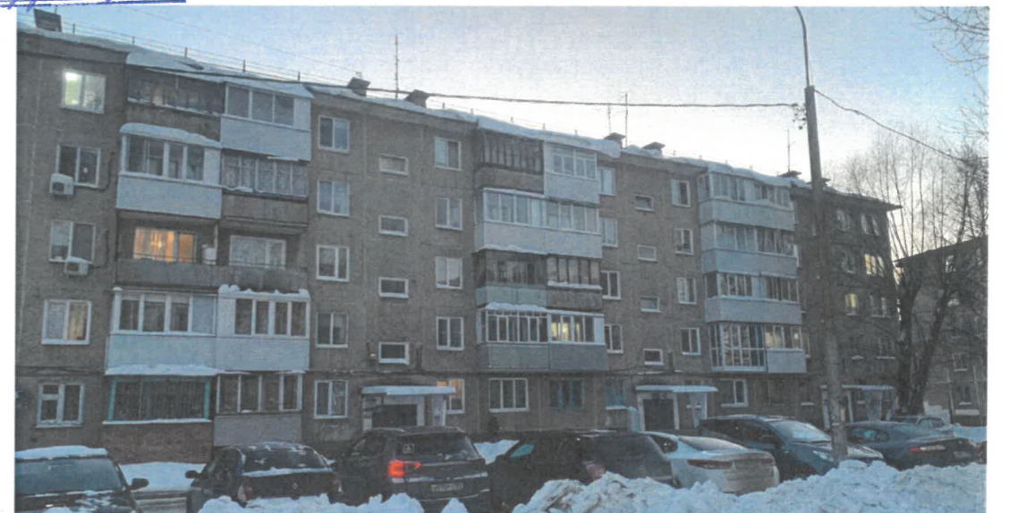
Существующее состояние главного фасада
