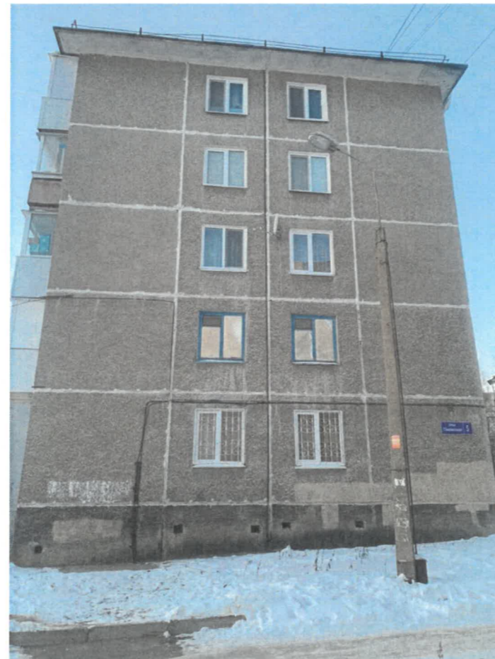
Существующее состояние бокового фасада
