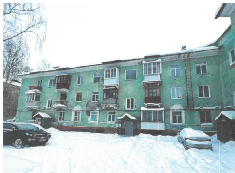
Дворовой фасад в осях 7 - 6
