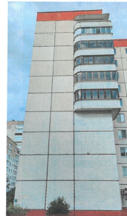
Фасад в осях Ж-Е
