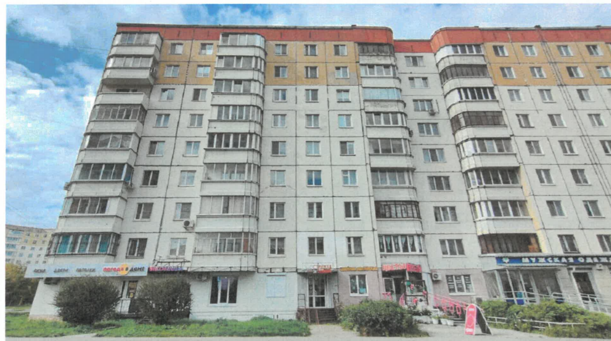
Фрагмент фасада в осях 1-3
