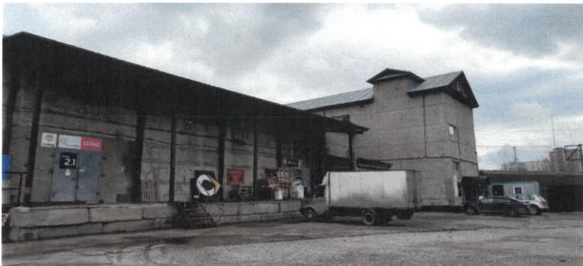
Боковой фасад (в осях 2-1), дворовой фасад
