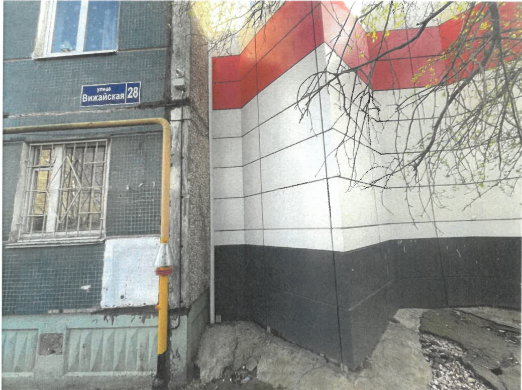
Существующее состояние бокового фасада
