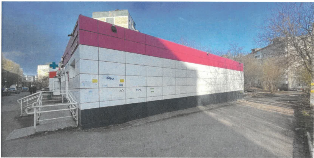
Существующее состояние бокового фасада
