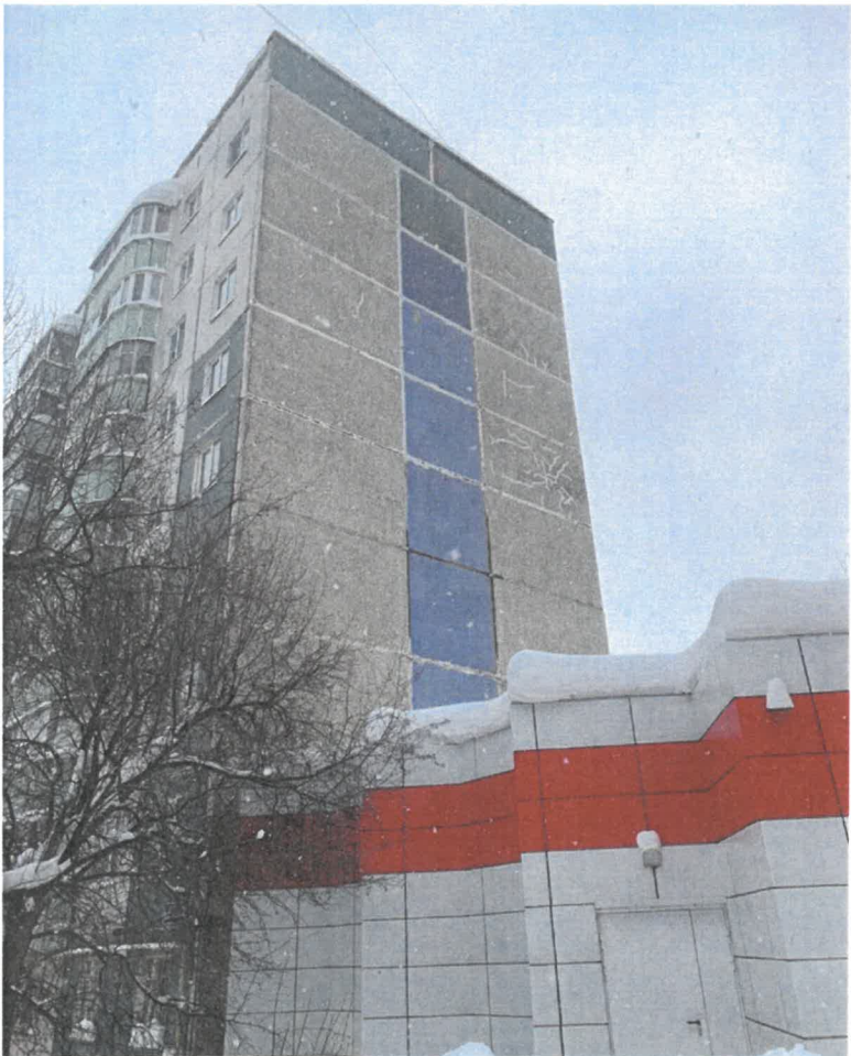
Существующее состояние главного фасада
