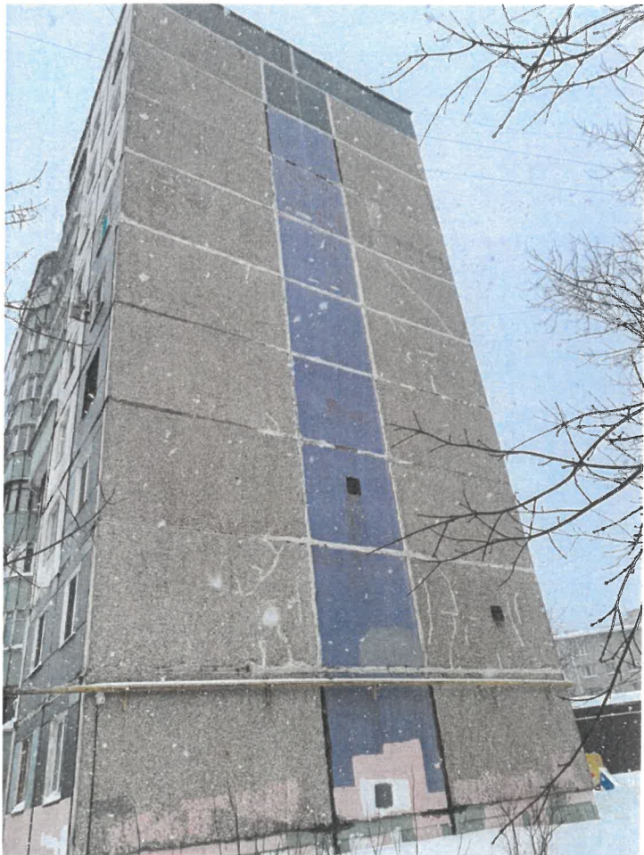
Существующее состояние бокового фасада
