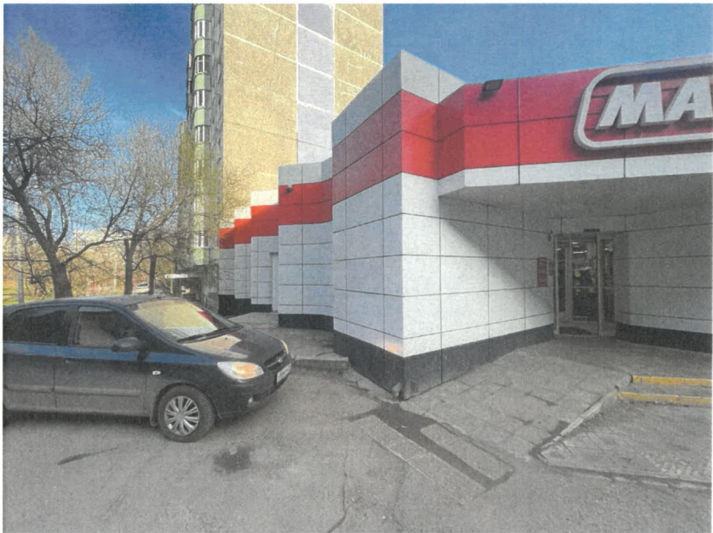
Существующее состояние бокового фасада
