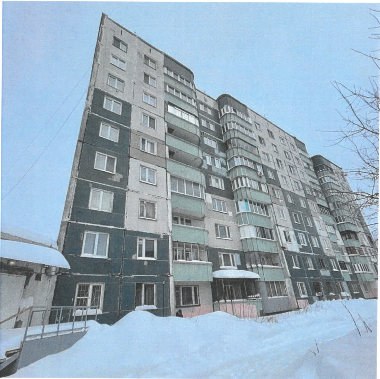
Существующее состояние дворового фасада
