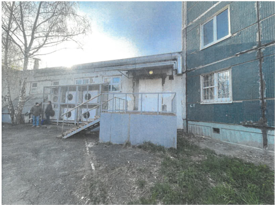
Существующее состояние дворового фасада
