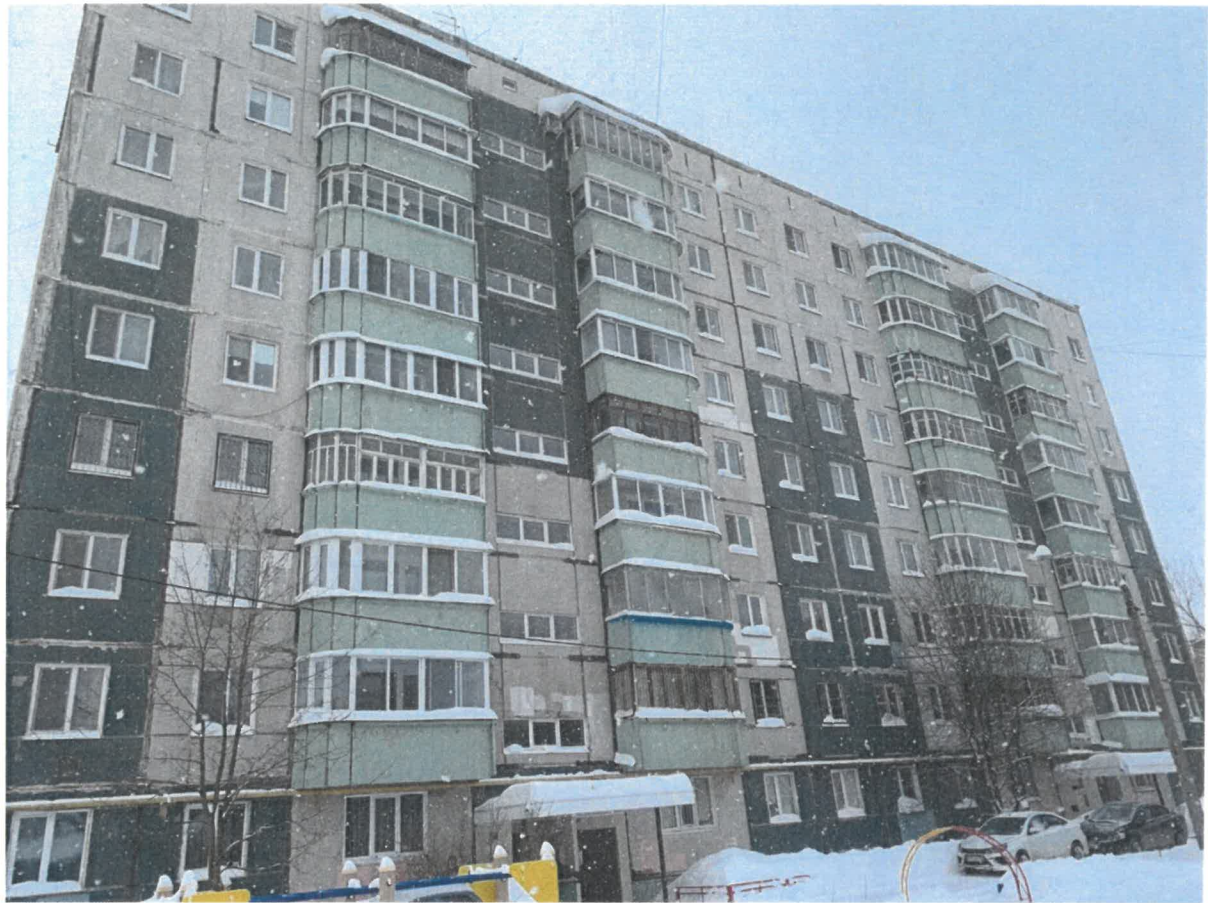
Существующее состояние бокового фасада
