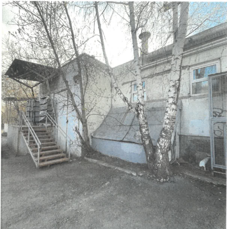
Существующее состояние дворового фасада
