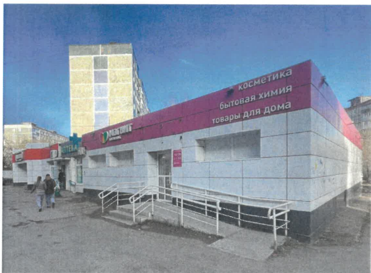
Существующее состояние главного фасада
