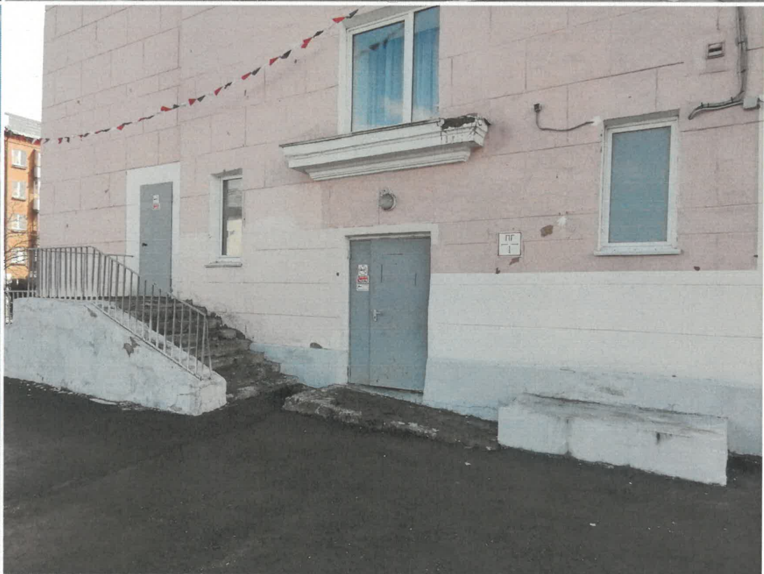
Фрагмент дворового фасада в осях 4-3
