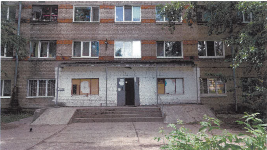
Боковой фасад (фрагмент)
