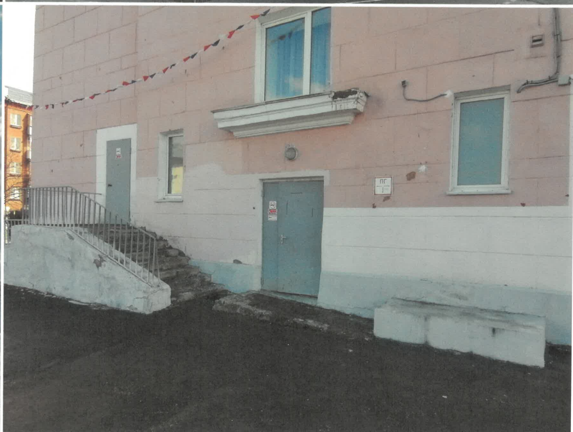
Фрагмент дворового фасада в осях 4-3
