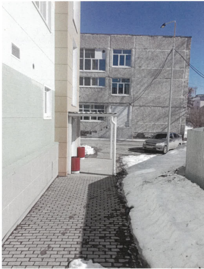
Боковой фасад (фрагмент)
