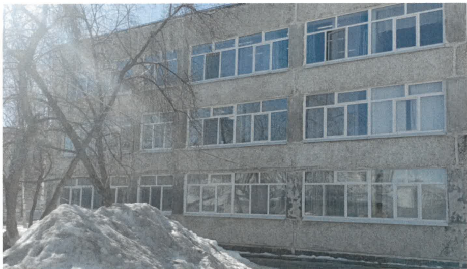
Боковой фасад (фрагмент)
