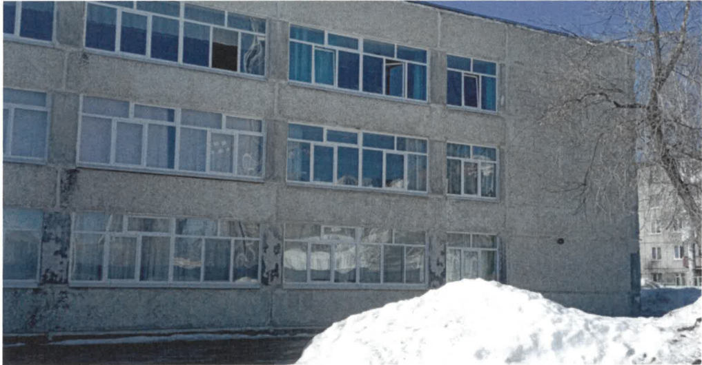
Боковой фасад (фрагмент)
