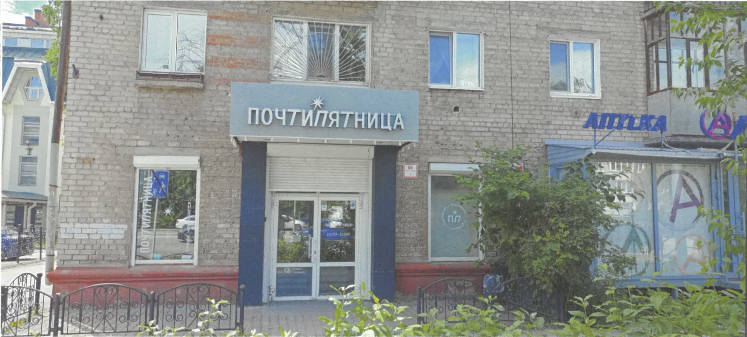
Фрагмент главного фасада
