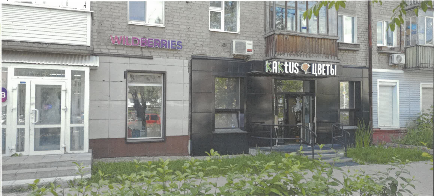
Фрагмент главного фасада
