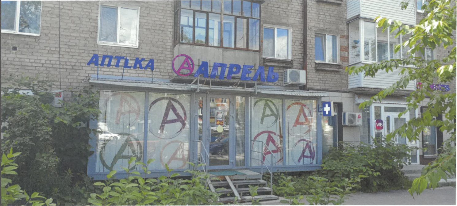
Фрагмент главного фасада
