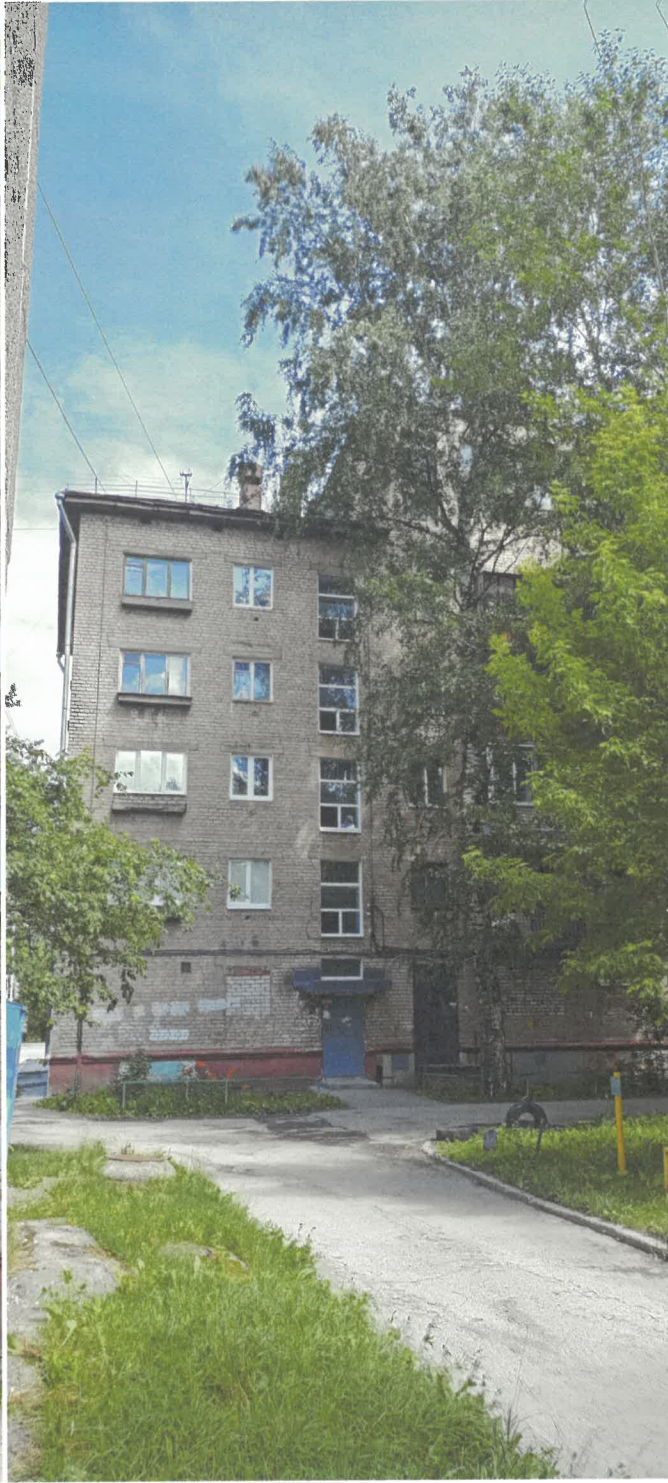
Фрагмент дворового фасада
