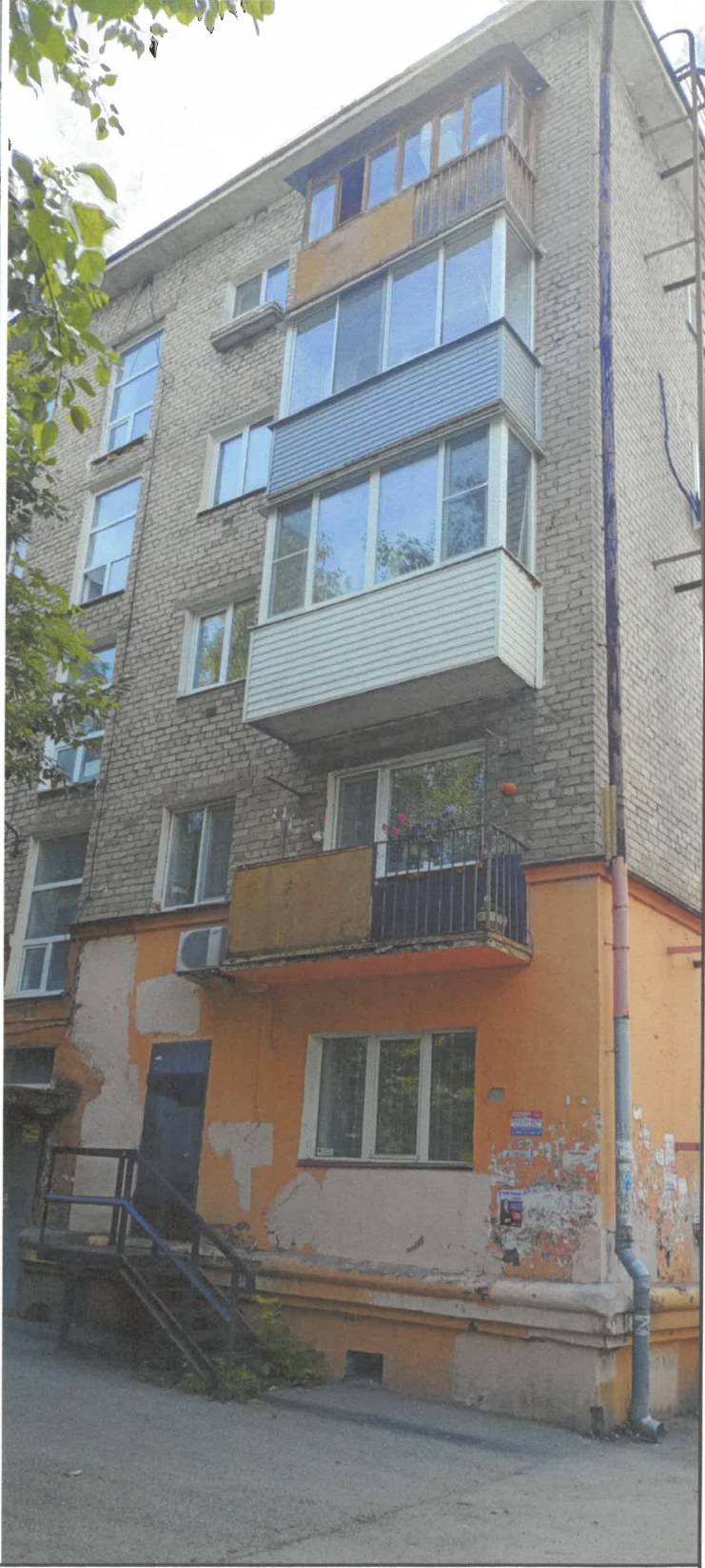
Фрагмент дворового фасада
