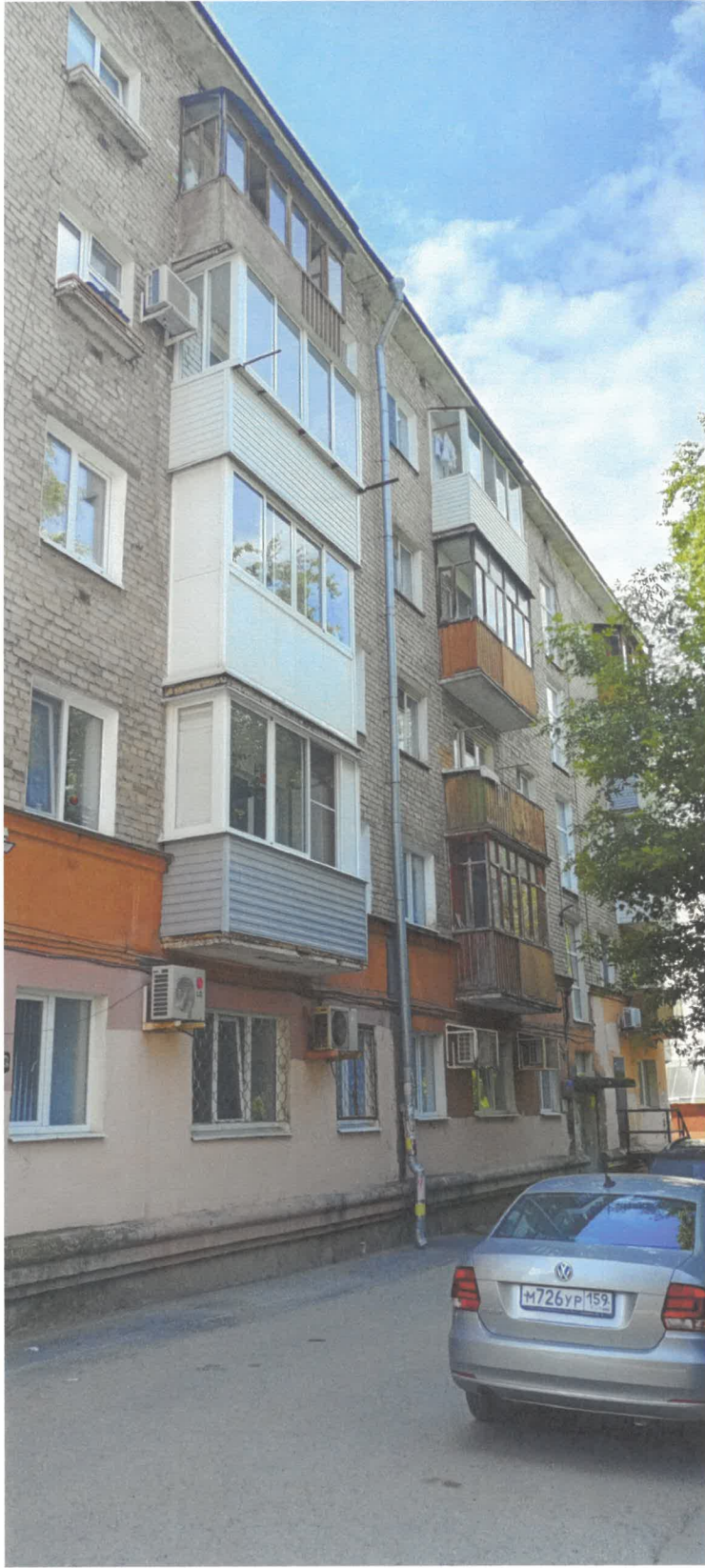
Фрагмент дворового фасада
