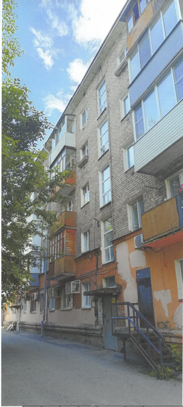
Фрагмент дворового фасада
