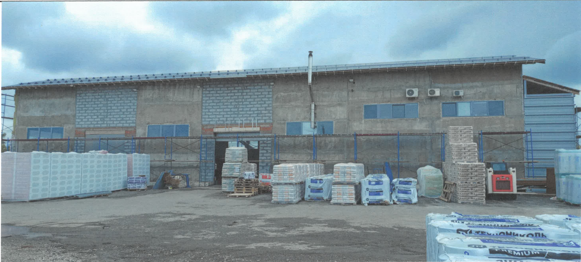
Вид на дворовой фасад 1-2 (фотофиксация)
