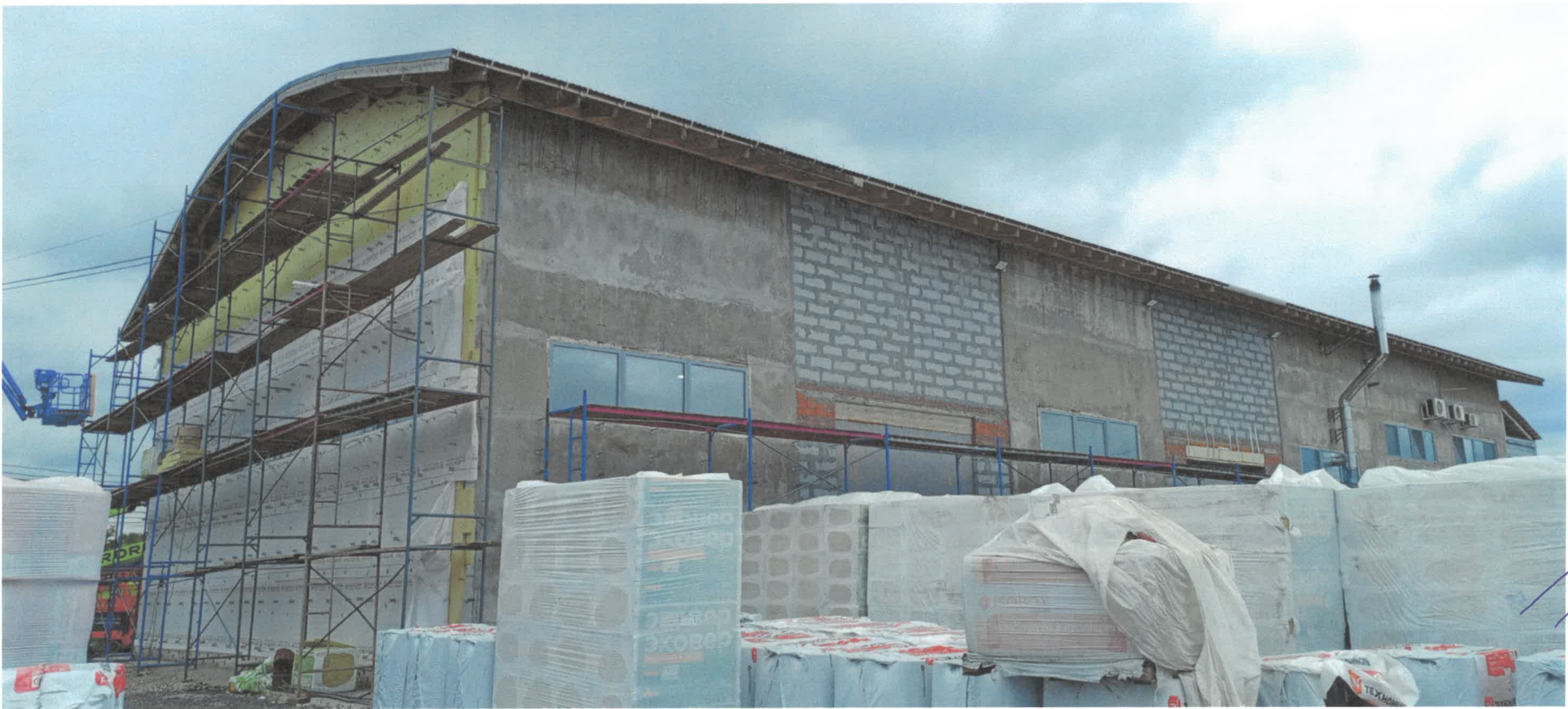
Вид на дворовой фасад 1-2 и боковой фасад Б-А (фотофиксация)
