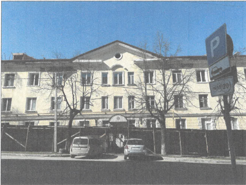
Существующие состояние главного фасада
