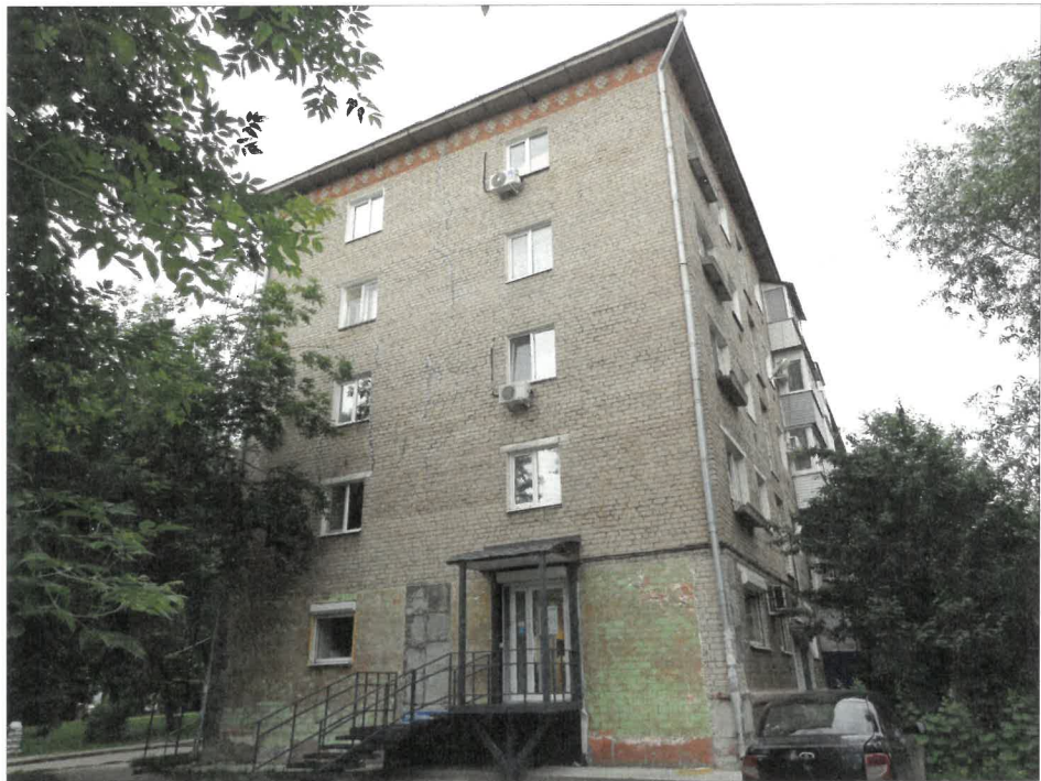
Фасад по ул. Космонавта Леонова
